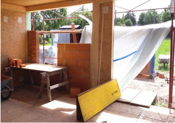
zwei unterschiedliche gemauerte Wandaufbauten links und rechts eines Fensters entstehen.
