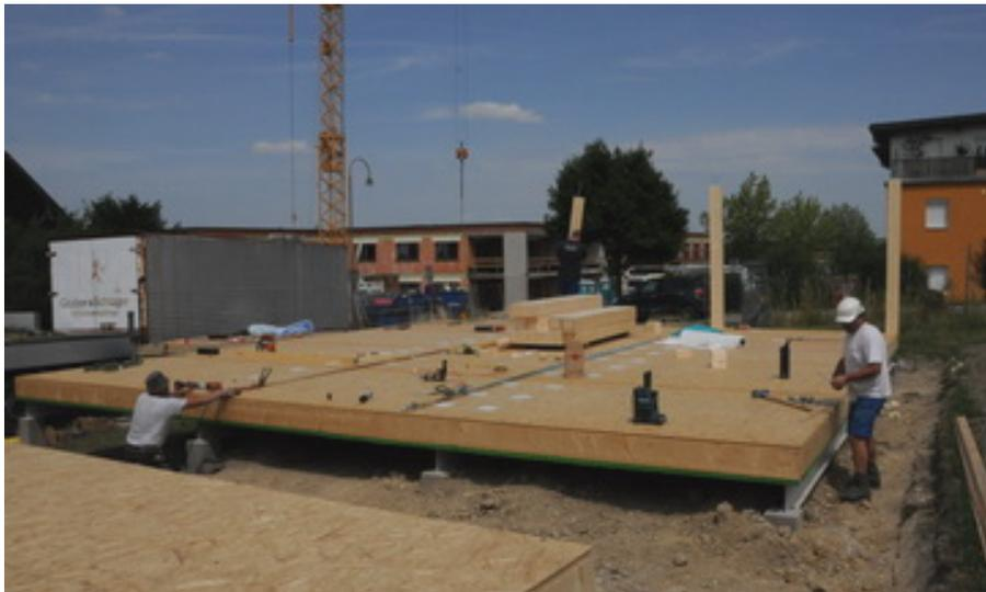
Die Elemente werden fixiert und ein Stützkranz wird aufgestellt
