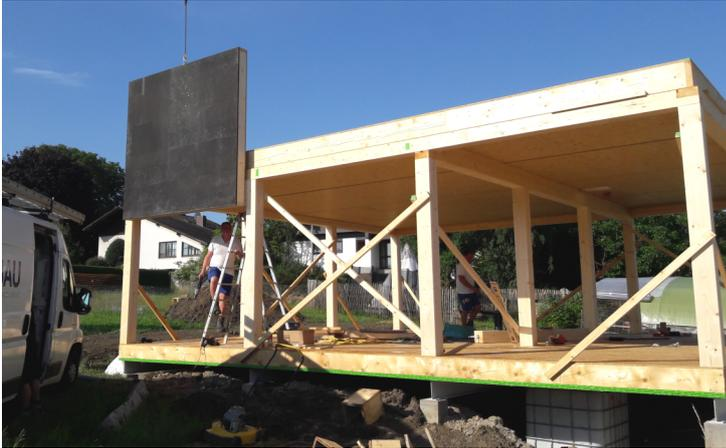
Das erste vorgefertigte Wandelement wird eingesetzt
