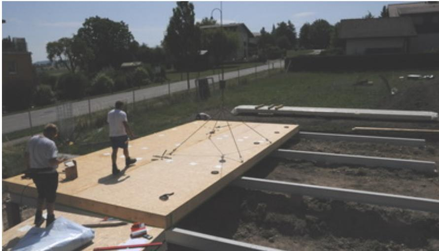
Bodenplatten werden auf die Schiene aufgelegt
