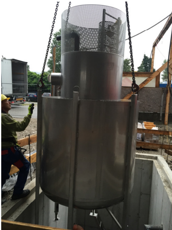
Abbildung 16: Einbringen Filter für Abwasserwärmerückgewinnungsanlage (20. August 2015) Foto: TB Stampfer
