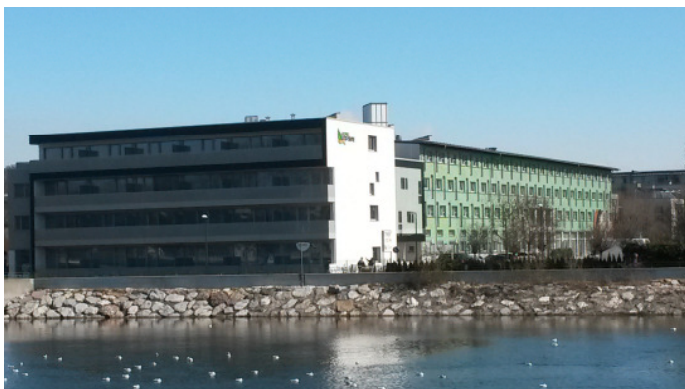
Abbildung 21: Gesamtgebäudekomplex mit Eco-Suite Hotel und Kolpinghaus Salzburg-Zentral Foto: Robert Freund
