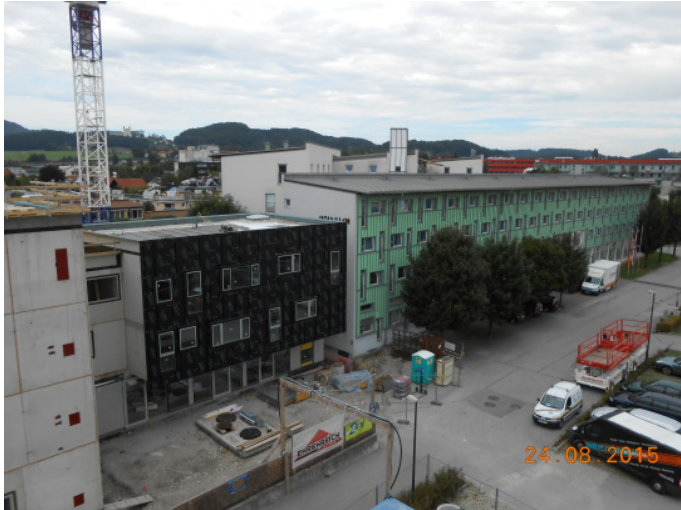
Abbildung 17: Baufortschritt am 24. August 2015 Foto: Wolfgang Lackner
