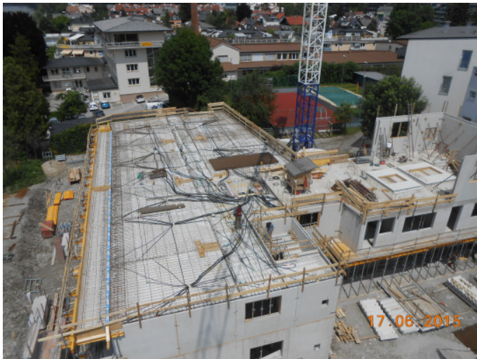
Abbildung 13: Baufortschritt am 17. Juni 2015 Foto: Wolfgang Lackner
