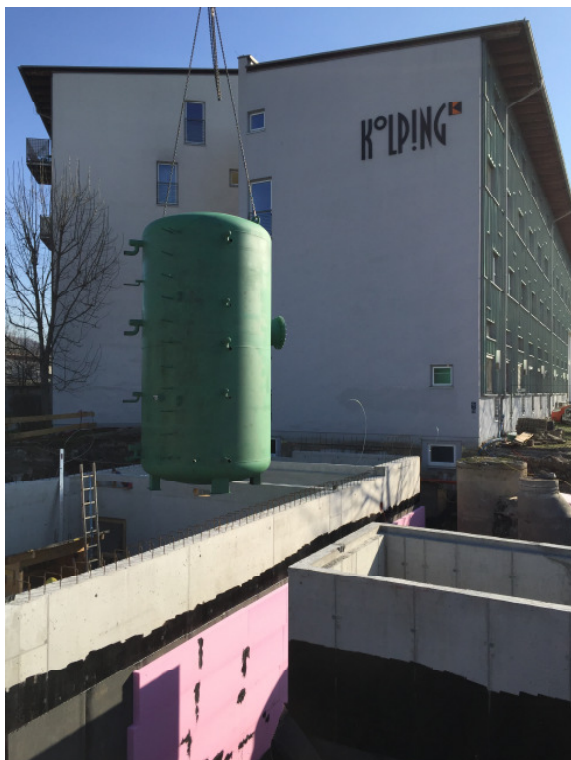
Abbildung 11: Einbringen Pufferspeicher (9. April 2015) Foto: TB Stampfer
