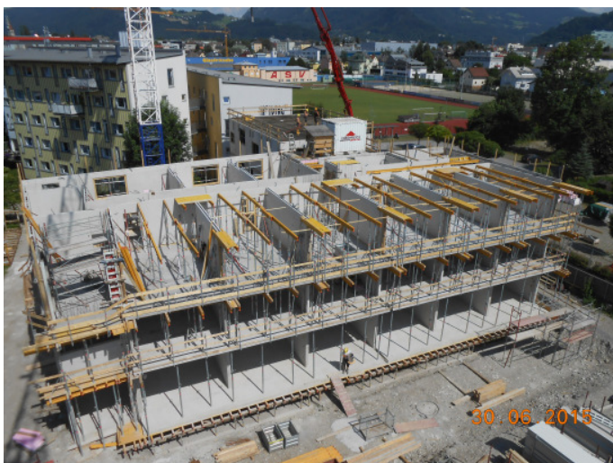
Abbildung 14: Baufortschritt am 30. Juni 2015 Foto: Wolfgang Lackner
