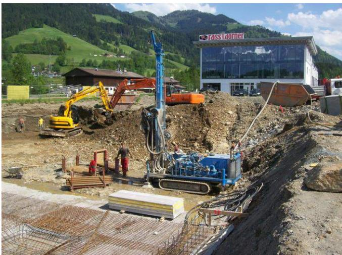
Bild: Erdsondenbohrungen für die Heizung und Kühlung der Arche Neo
