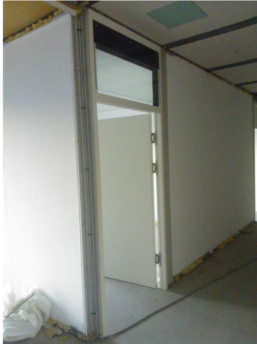
Abbildung 16: Tageslichtversorgung im Gangbereich - Bauphase (Quelle: ATP architekten ingenieure)
