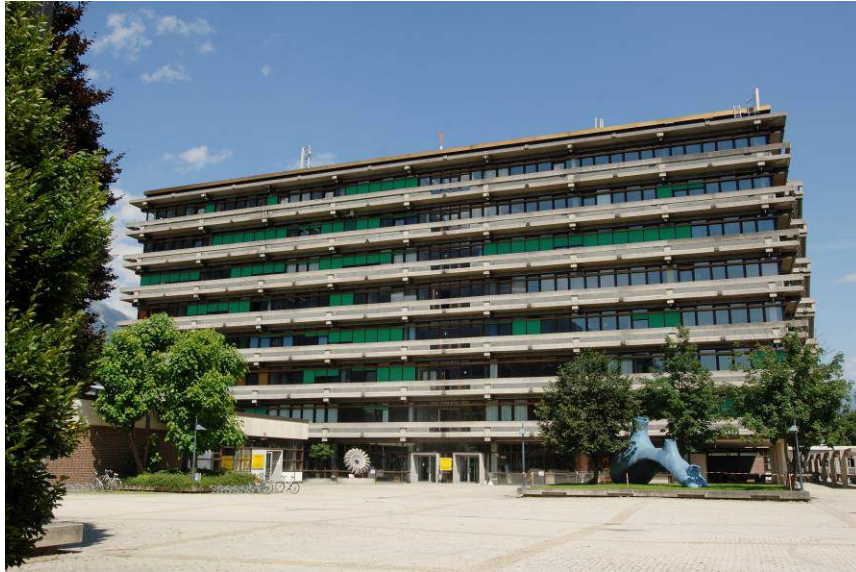
Abbildung 7: Hauptgebäude der Baufakultät vor der Sanierung (Quelle: Universität Innsbruck)
