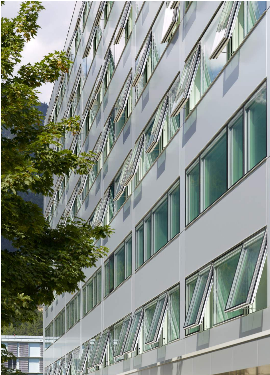
Abbildung 9: Ansicht Fassade und Fensterelemente (Quelle: ATP architekten ingenieure)
