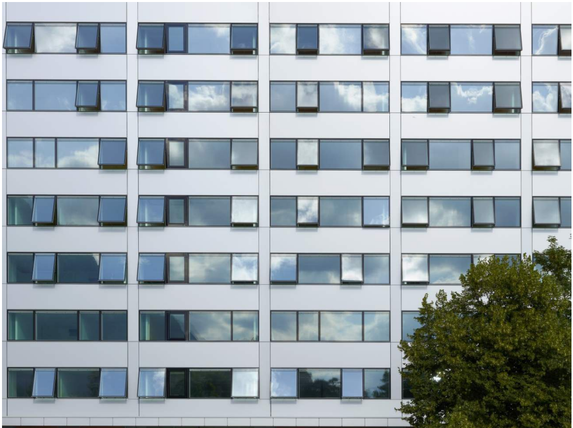
Abbildung 11: Fassade und Senk-Klapp-Fenster im fertigen Zustand (Quelle: ATP architekten
