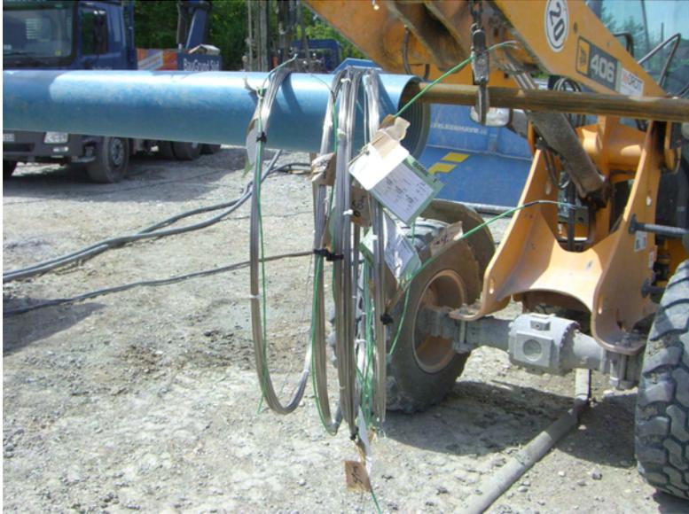
Abbildung 1: Mantelthermoelemente unterschiedlicher Länge
