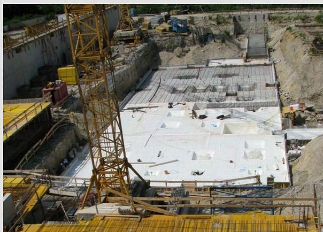
Diese Isolierung auch „Weiße Wanne“ genannt, dient als zusätzlicher Schutz gegen das Eindringen von Grundwasser.
