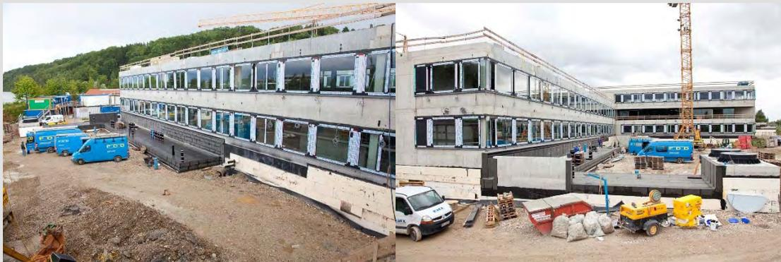
Da die Betonierarbeiten im Gebäude größtenteils abgeschlossen sind, wurden schon alle Baukräne von der Baustelle entfernt. Ebenfalls durchgeführt wurden die Grabungsarbeiten für den Kanal, die Wasseranschlüsse und Straßenquerungen für das Geothermiefeld im Zufahrtsbereich.
