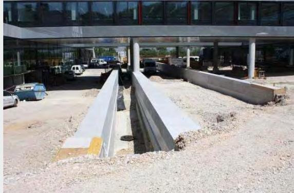
/ Weiters konnte die Außenanlage im Ostteil von T2 mit den Lüftungskaminen und der Feuerwehrezufahrt fertig gestellt werden.
