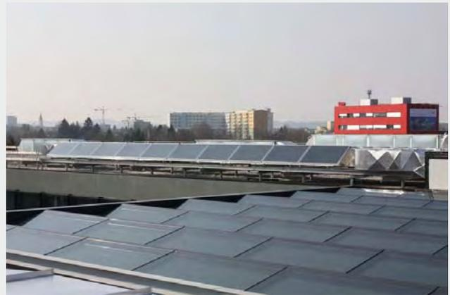
/ Alle Module der geplanten PV Anlage wurden vorab definiert. Die thermische Solaranlage für die Warmwasseraufbereitung des Betriebsrestaurants ist bereits umgesetzt. Ebenfalls so die Schotterschüttung auf der Dachfläche bereits aufgebracht.
