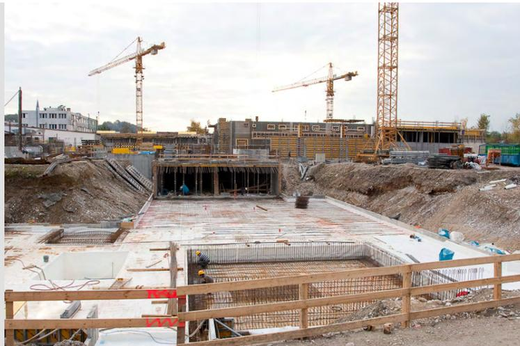
Bis jetzt ist auf der Baustelle ausschließlich Flüssigbeton zum Einsatz gekommen. Am Montag den 2. November beginnt die Baufirma Gerstl mit dem Aufstellen der ersten Fertigbetonträger im Hallenbereich des BT2.
