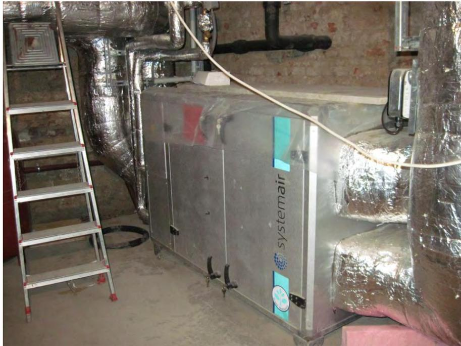
Abbildung 39: Zentrales Lüftungsgerät im Keller [Quelle: Andreas Kronberger]
