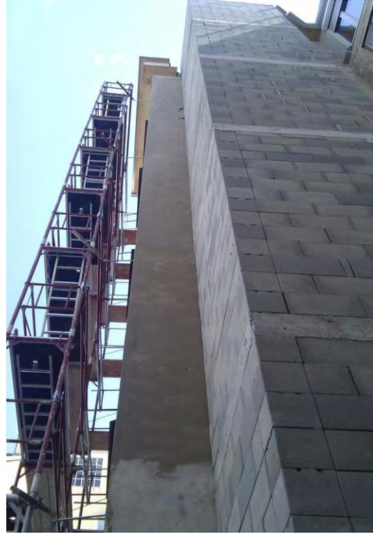
Abbildung 23: Neuer Aufzugschacht aus Betonschalsteinen [Quelle: Andreas Kronberger]
