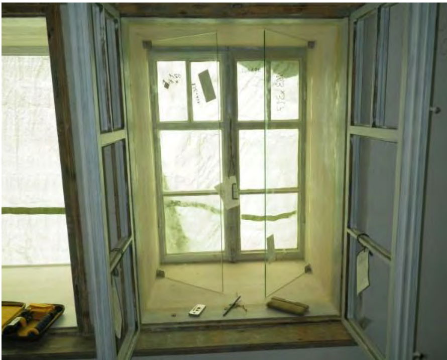
Abbildung 39: Stockverlängerung des Bestandsfensters mit zusätzlich eingebauten Glaselementen zur Verbesserung der thermischen Dämmung
