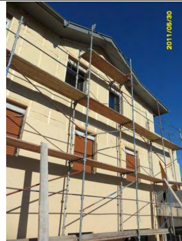
Anbringung der Dämmschicht an der südlichen Außenfassade – August 2011
