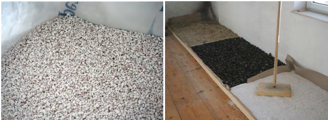
Abbildung 33: Perlitschüttung (Volcalitgestein) auf Rieselschutzfolie (Baupapier) (links) – 3 Varianten (Hanf-Lehm-Schüttung, Glasschaumschotter, Perlitschüttung) im Überblick (rechts)
