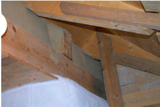
Dokumentation der luftdichten Ausführung der Dachanschlüsse (Lehmschlämme) 02/2012
