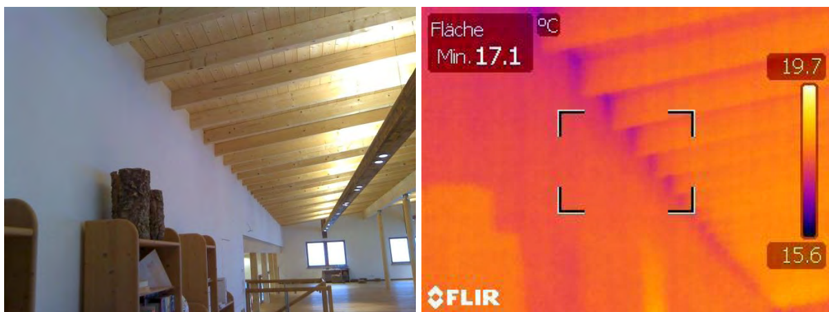
Abbildung 43: Aufnahmen eines Demonstrationsgebäudes nach der Sanierung (links: Photographie, rechts: Thermographie)
