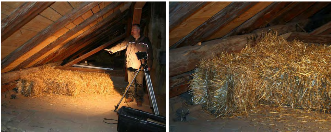
Abbildung 34: Während der Errichtung der lasttragenden Strohballendämmung (links); Detail der Strohballendämmung (rechts)
