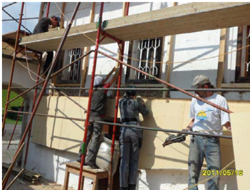
Anbringen der Holzweichfaserplatten auf der Holzunterkonstruktion (05/2011)
