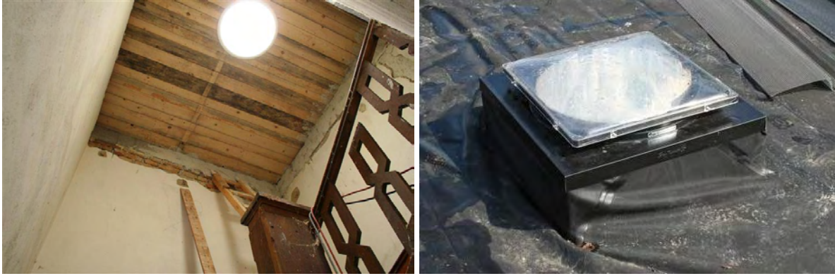
Abbildung 38: Links: Fertig eingebauter Tageslichtkollektor vom Treppenhaus aus betrachtet (Bauzustand); rechts: Tageslichtkollektor auf dem Dach mit angeschlossener EPDM-Folie
