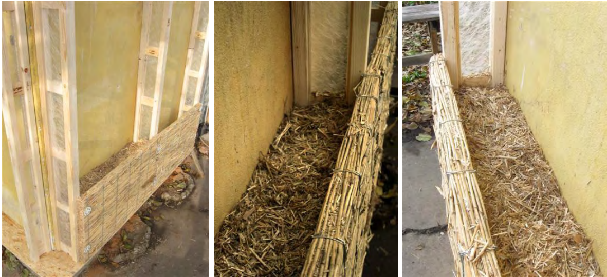
Abbildung 29: Schilfhäcksel-schüttung in Stegträgerkonstruktion, Abschluss mit einer Schilfrohrplatte
