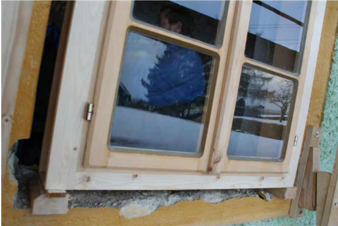
Abbildung 37: Außenansicht eines neu eingebauten Fensters mit Setzhölzern
