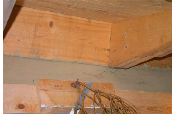
Dokumentation der luftdichten Ausführung der Dachanschlüsse (Lehmschlämme) 02/2012
