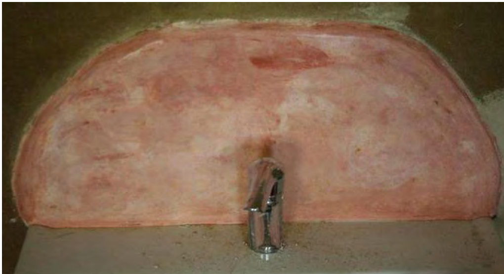
Abbildung 41: Ausbildung des Spritzwasserbereichs oberhalb eines Waschbeckens in Tadelakt, rundherum anschließend Lehmputz
