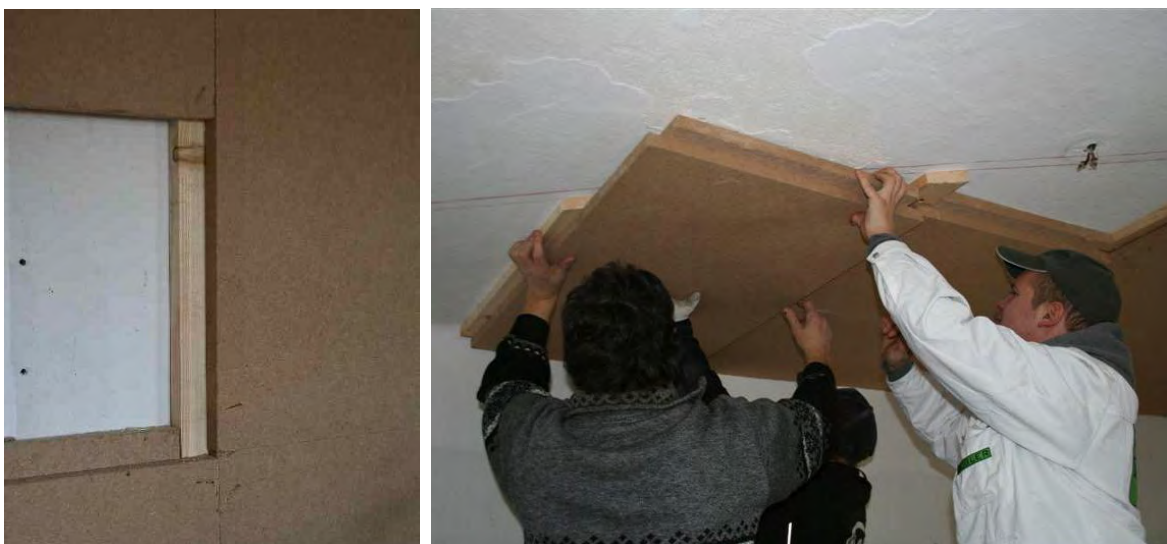
Abbildung 31: Holzweichfaserplatten mit Montageleisten an Wand und Decke
