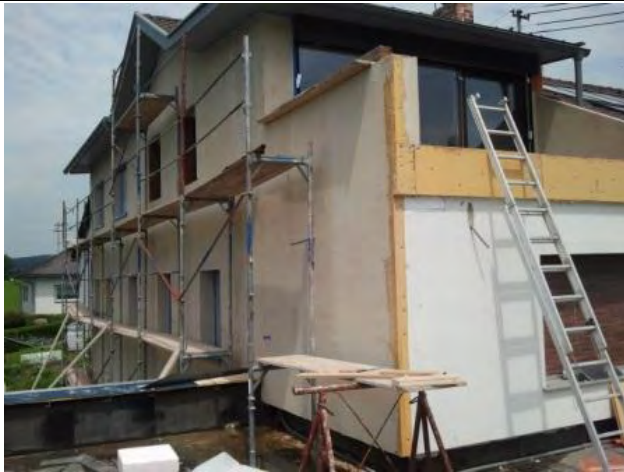
Anbringung der Dämmschicht an der südlichen Außenfassade – August 2011
