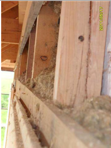
Einbringen der Flachsdämmung zwischen die Holzunterkonstruktion (05/2011)
