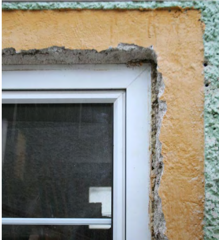
Abbildung 106: Vom Außenputz befreites Bestandsfenster (Isolierglas) – Zone 1
