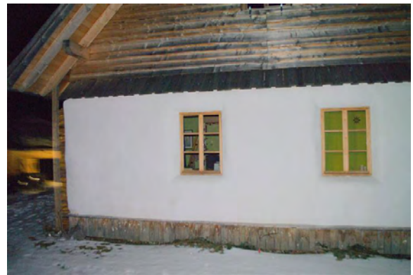
Dokumentation der Außenflächen (Lehmputz mit Kalkfarbe) – 12/2011
