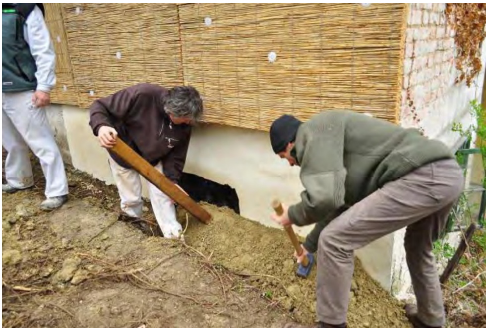
Abbildung 27: Ausführung der Fundamentabdichtung in Form eines Lehmschlages an der Lehrbaustelle unterhalb der bereits angebrachten Schilfrohrdämmung – Böheimkirchen 2012
