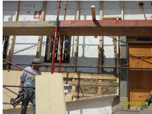
Anbringen der Holzweichfaserplatten auf der Holzunterkonstruktion (05/2011)
