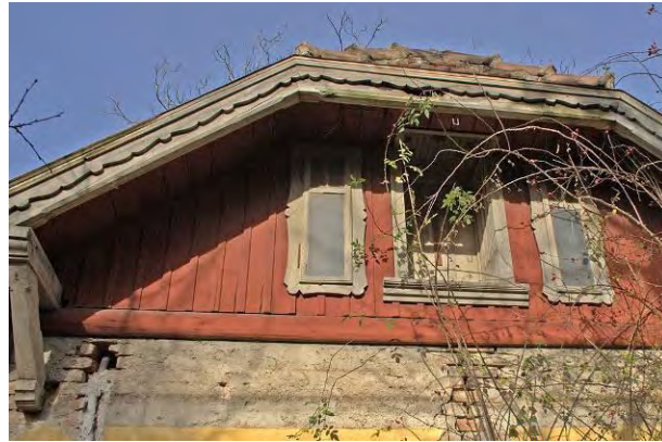
Abbildung 62: Holzkonstruktion im Obergeschoß des Giebelbereichs
