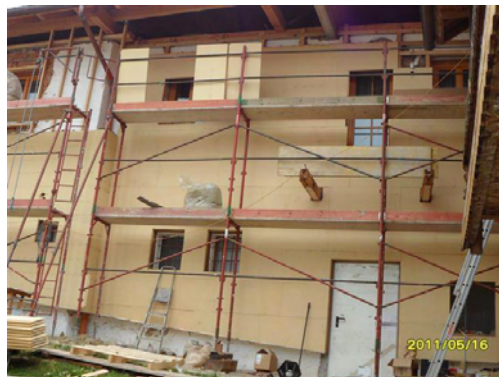
Anbringen der Holzweichfaserplatten auf der Holzunterkonstruktion (05/2011)
