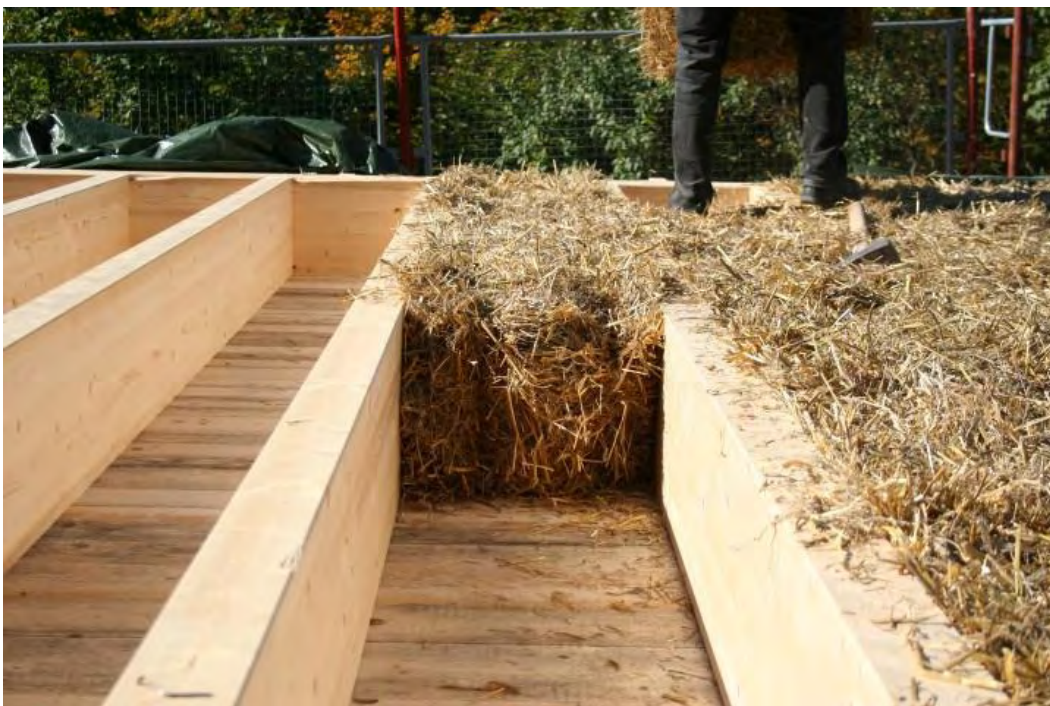
Abbildung 36: Einbringung der Strohballendämmung in die vorbereitete Holzkonstruktion der Dachebene
