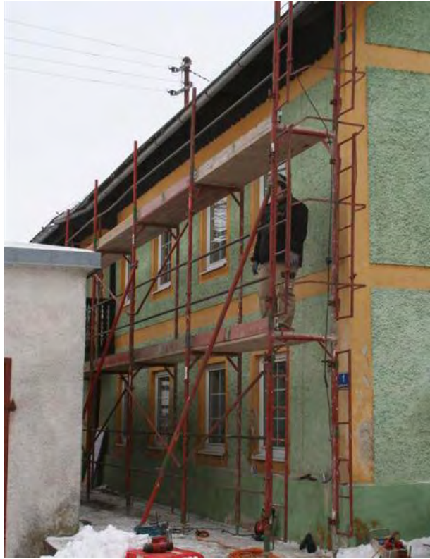
Abbildung 98: Ansicht der für die Außendämmung gewählten Zone 1
