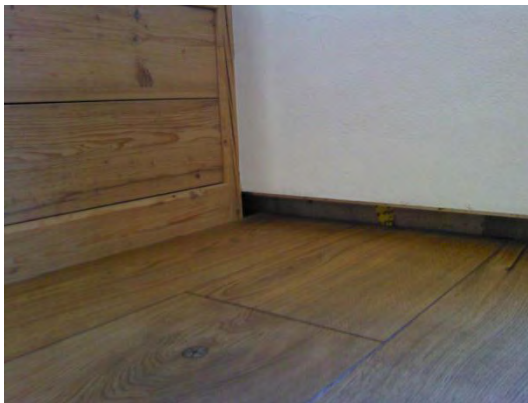
Überprüfung auf Wärmebrücken und luftdichte Ausführung (Sockelzone innen) – 02/2012
