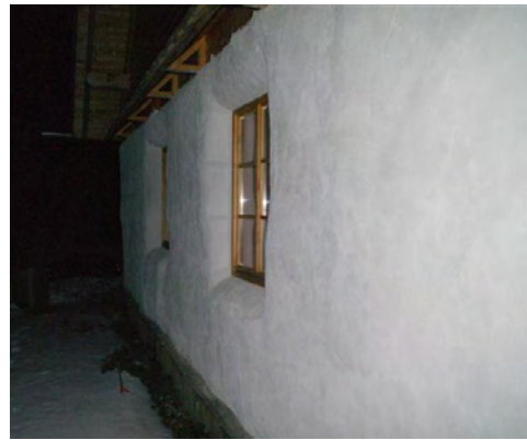
Dokumentation der Außenflächen (Lehmputz mit Kalkfarbe) – 12/2011
