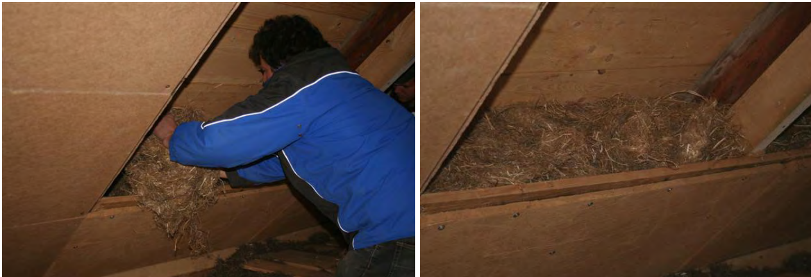
Abbildung 35: Einbringung des Stopfhanf-Dämmstoffes in die vorbereiteten Kammern
