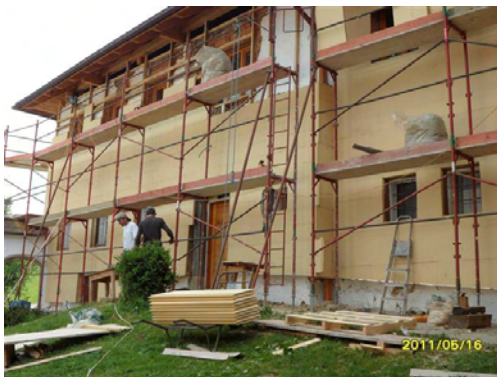
Anbringen der Holzweichfaserplatten auf der Holzunterkonstruktion (05/2011)
