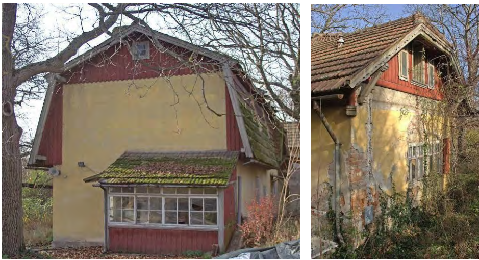
Abbildung 54: Ansichten Sanierungsobjekt „Wohnhaus Riedl“ Böheimkirchen
