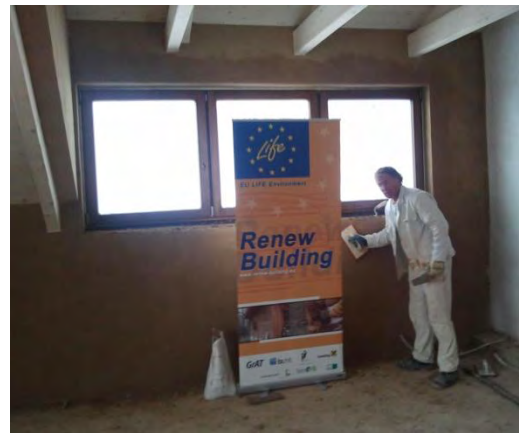
Aufnahmen während der Erstellung der Innendämmung / Lehmputzauftrag
