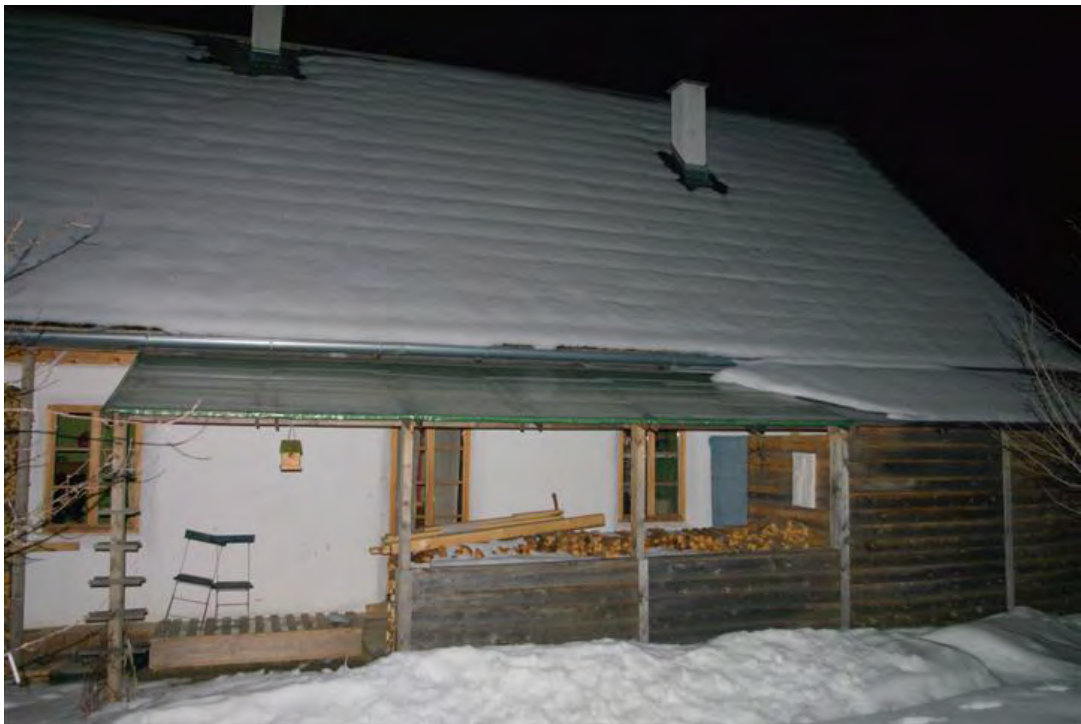
Dokumentation der Außenflächen (Lehmputz mit Kalkfarbe) – 12/2011
