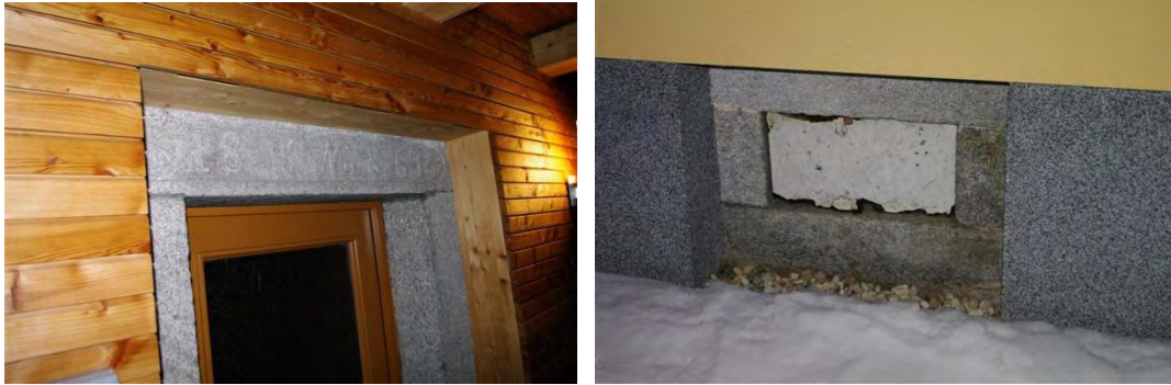
Dokumentation einzelner Bauteile (links: Eingangstür mit Granitsockel, rechts: Kellerfenster) (02/2012)
