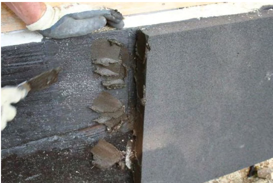
Abbildung 26: Verklebung der Glasschaumplatten auf die mit Bitumenanstrich abgedichtete Ytongebene sowie auf die darunterliegende Fundamentebene
