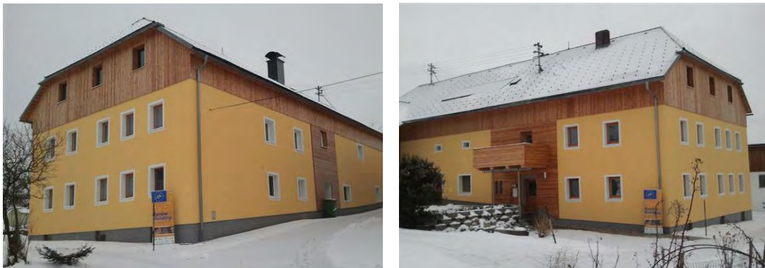
Fertig gestellte Außenfassaden (12/2011)
