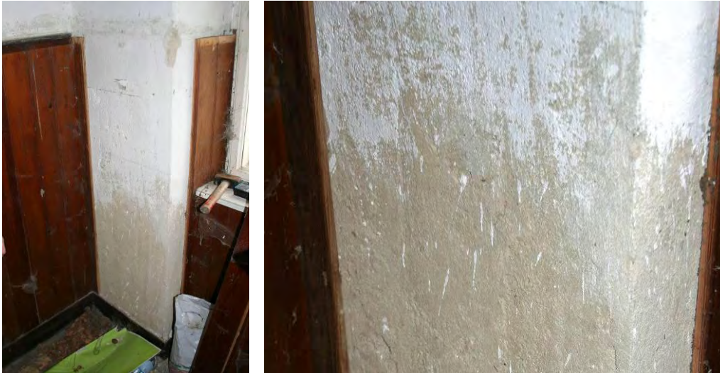
Abbildung 73: Freigelegtes Wandsegment hinter Holzvertäfelung im Erdgeschoß
