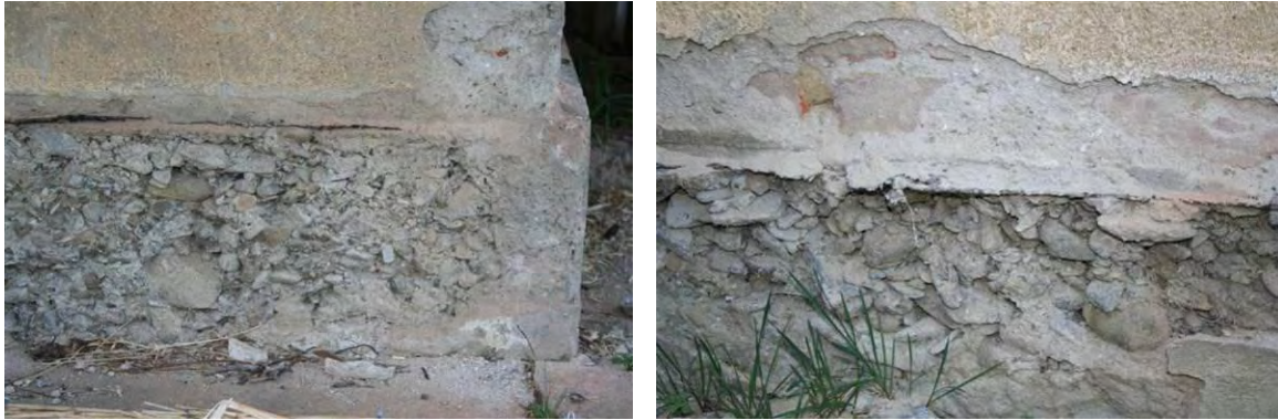
Abbildung 69: Sockelzone der Außenwand mit freigelegter Bodenplatte
