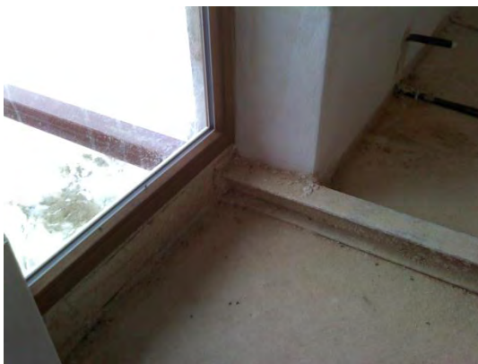
02/2012 – Nicht fertiggestellter Fußboden – Überprüfung der Luftdichtheit im Bereich der AW AW
