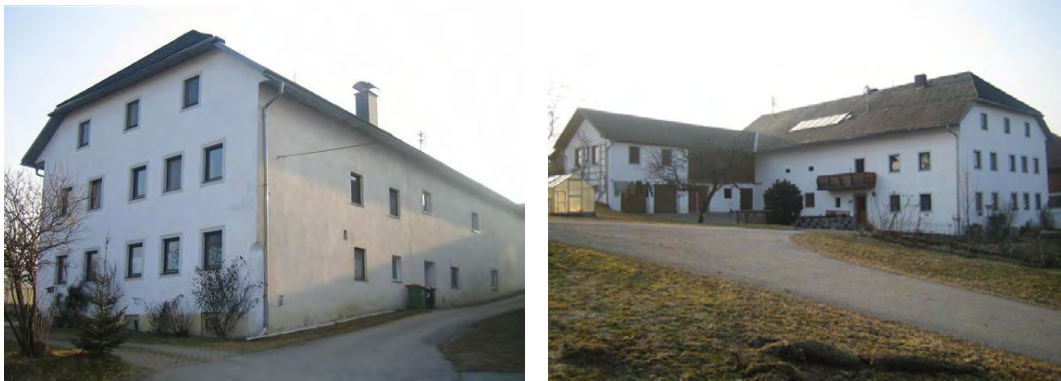
Bestandsaufnahme VOR Beginn der Sanierungsarbeiten (02/2011)
