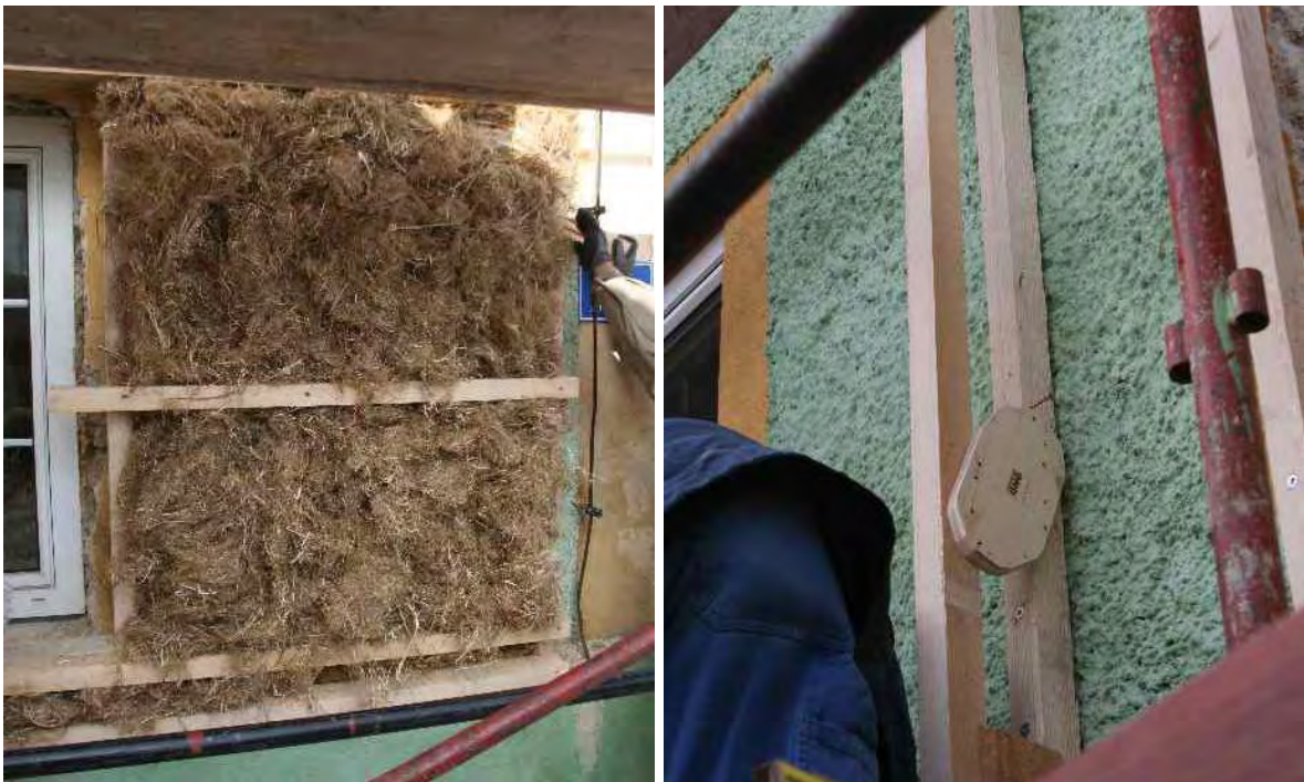
Abbildung 28: Fertiggestellter Bereich der Stopfhanf-Dämmung / Anbringung der alternativen Holzunterkonstruktion (System Doser)
