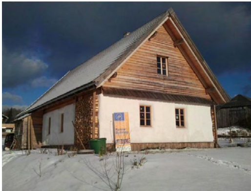
Dokumentation der Außenflächen (Lehmputz mit Kalkfarbe) – 12/2011
