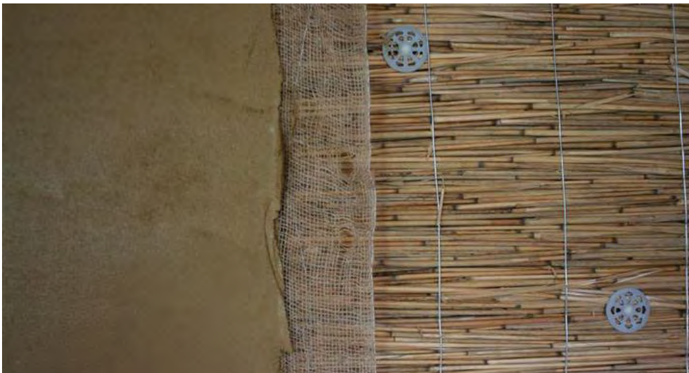
Abbildung 40: Lehmfeinputz mit Armierungsgewebe (Jutenetz) auf Schilfrohrplatte
