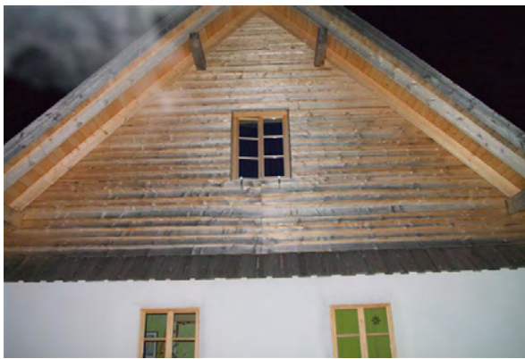
Dokumentation der Außenflächen (Lehmputz mit Kalkfarbe) – 12/2011
