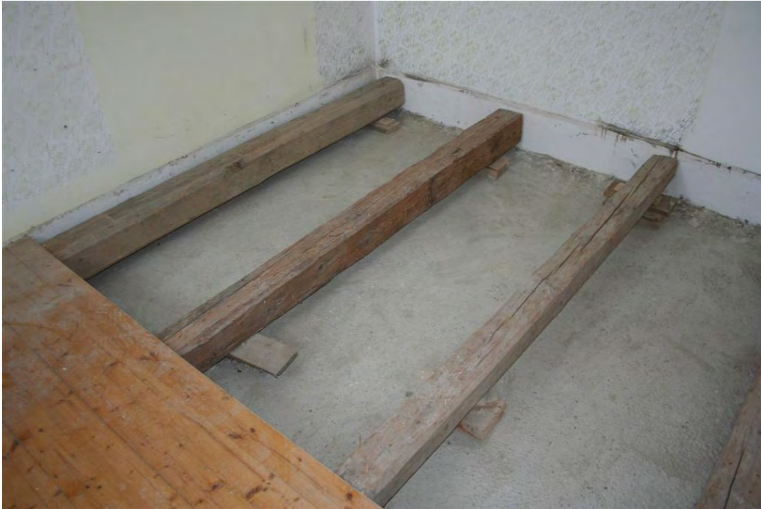
Abbildung 105: Vollständig freigelegte Deckenbalken – Zone 4
