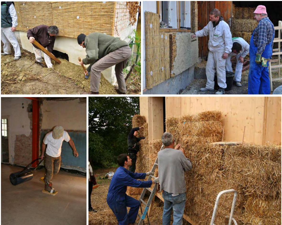
Abbildung 22: Praxistrainings an verschiedenen Bauteilprototypen an der Lehrbaustelle Böhheimkirchen
