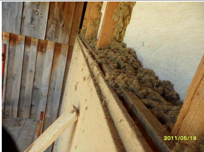
Einbringen der Flachsdämmung zwischen die Holzunterkonstruktion (05/2011)
