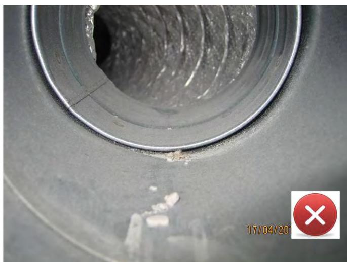
**Abbildung 27: Zuluftleitung vor Zuluftdurchlass**
