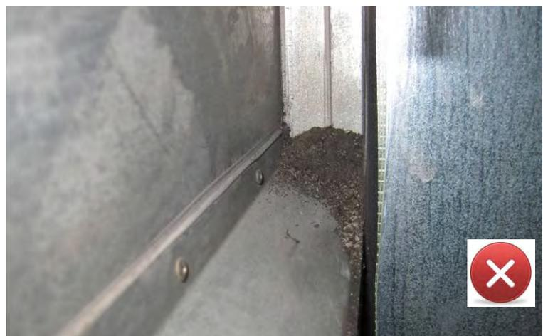
**Abbildung 18: Staubablagerung im Kompaktgerät**
