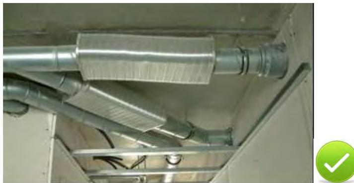
**Abbildung 83: vorteilhafte Verwendung von 45°- Bögen und 45°-Abzweigern**
