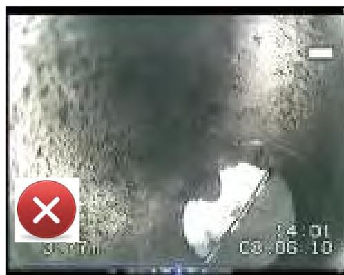
**Abbildung 36: Abluftleitung mit geschlossener Klappe**
