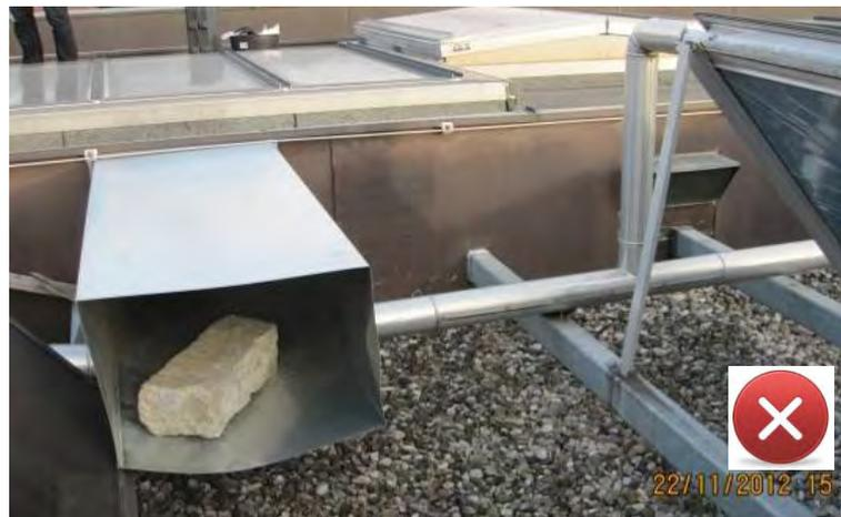
**Abbildung 14: Nachträgliche unprofessionelle Verlängerung der Außenluftansaugung zur Vermeidung von Geruchsübertragung.**
