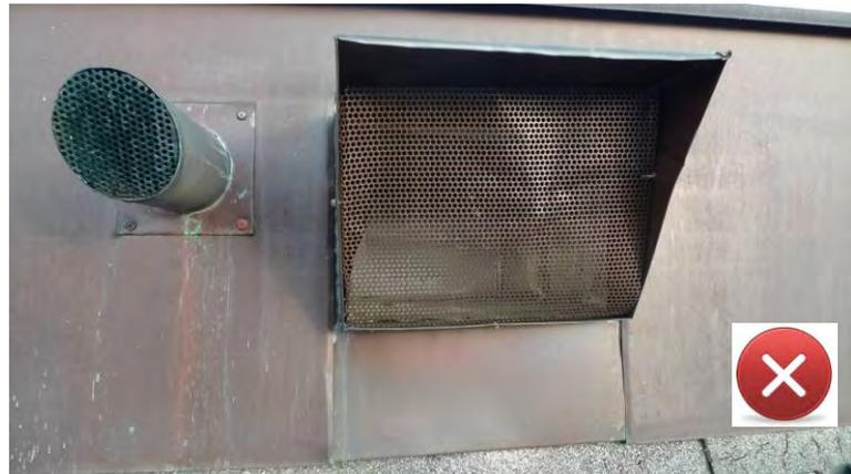
**Abbildung 13: Außenluftansaugung neben Fallstrangentlüftung**
