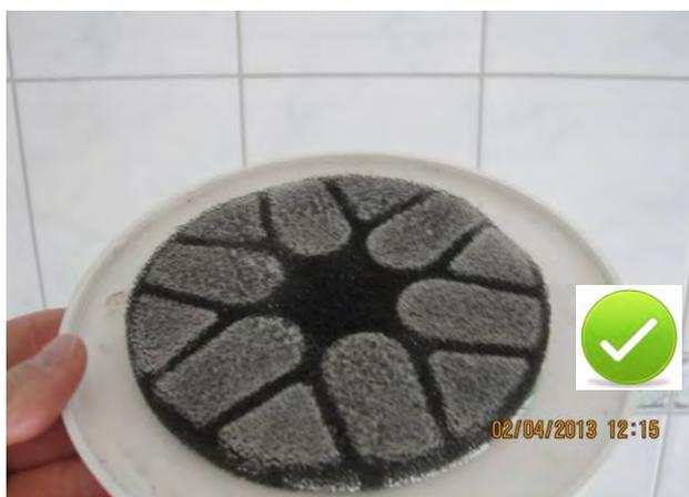
**Abbildung 33: Flusenfilter bei Abluftdurchlass**
