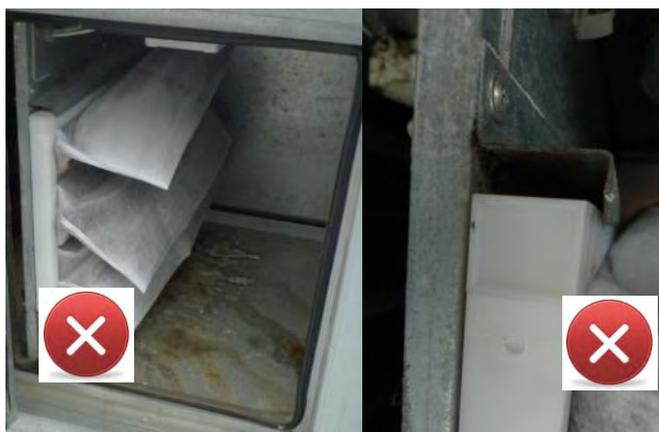
Abbildung 20: Taschenfilter 1. Filterstufe, Filtereinbausituation
