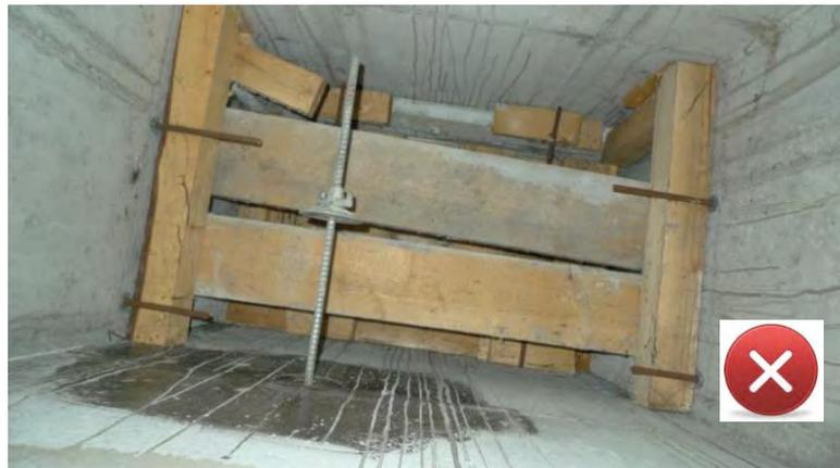
**Abbildung 16: Außenluftschacht (vergessene Schalung)**
