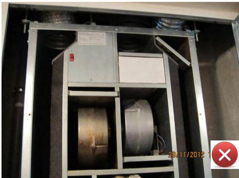
**Abbildung 23: Ablagerungen von Rauchinhaltsstoffen im Lüftungsgerät**
