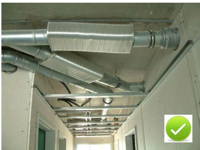
**Abbildung 24: Strömungsgünstige und reinigungsfreundliche Ausführung mit 45°-Abzweiger.**
