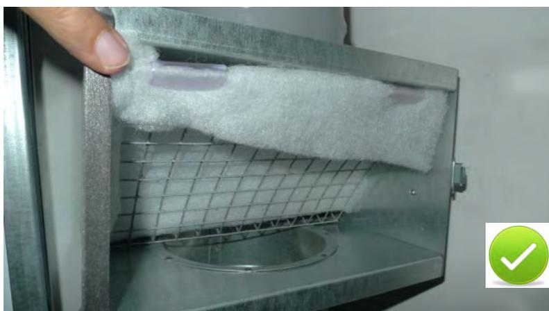
**Abbildung 22: Filter richtig positioniert**
