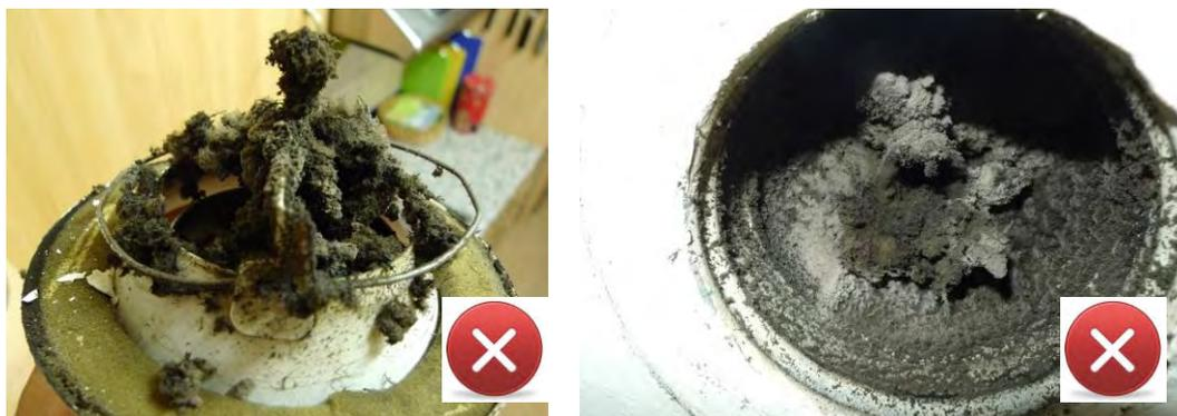
Abbildung 31: Staub- und Flusenablagerungen in den Ablufleitungen nach mehrjährigem Betrieb.
