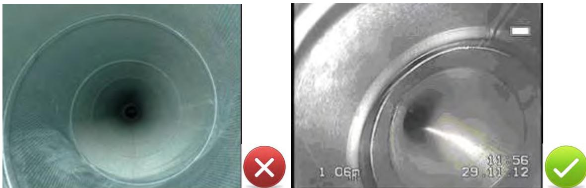
Abbildung 85: Zuluftleitungen mit Grenzwertiger und akzeptabler Sauberkeit
