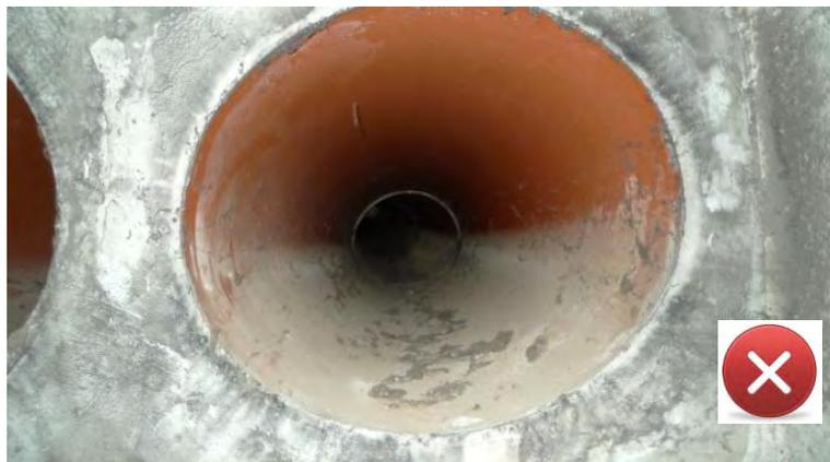
**Abbildung 15: Stark mit Grobschmutz verunreinigtes, erdverlegtes Außenluftrohr**
