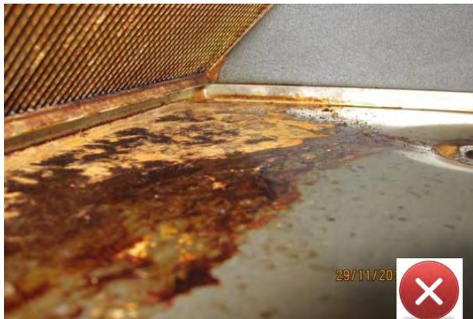
**Abbildung 25: Blick ins Lüftungsgerät einer Raucherwohnung**
