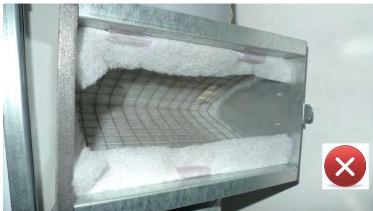
**Abbildung 21: Filter falsch positioniert**
