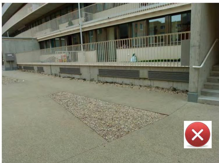
**Abbildung 10: Außenluftansaugung in zu geringer Höhe**
