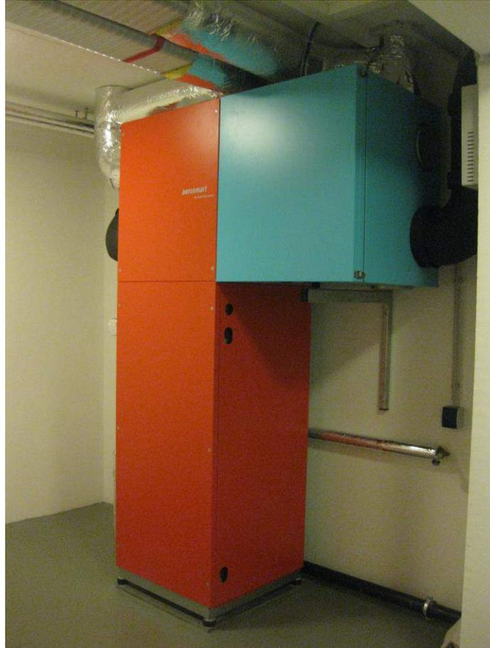
Abb. 3.5 Komfortlüftung mit Kleinstwärmepumpe zur Grundlastabdeckung
