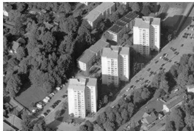
Wohnhochhaus der 1970er Jahre
