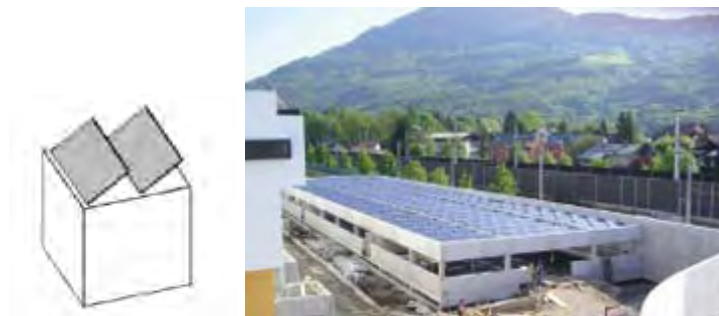
Abbildung 13: Schemazeichnung und Beispiel von Solarkollektoren auf Flachdach.
