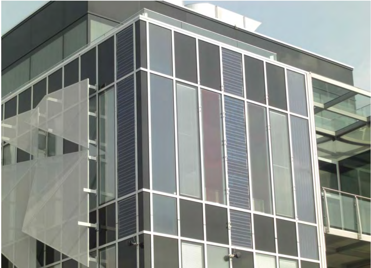
Abbildung 20: Die multifunktionale Testfassade am Bürogebäude der FIBAG (Hans Höllwart Forschungszentrum für integrales Bauwesen
