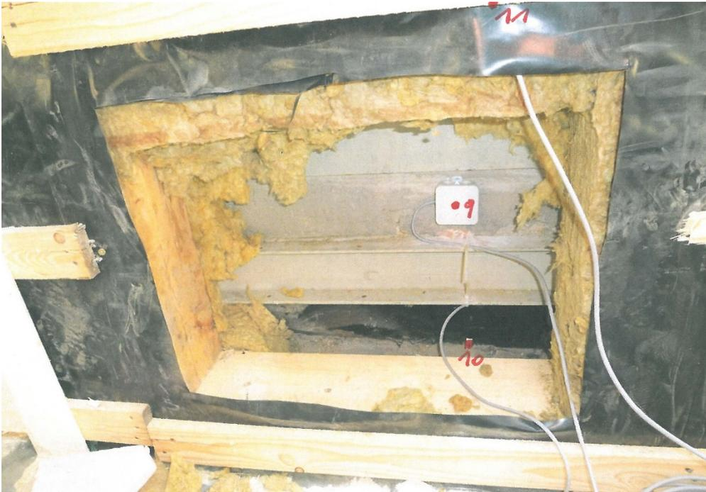
Abbildung 77: Lagebezeichnung der Sensoren S9 bis S11 am Drempelmauerwerk
