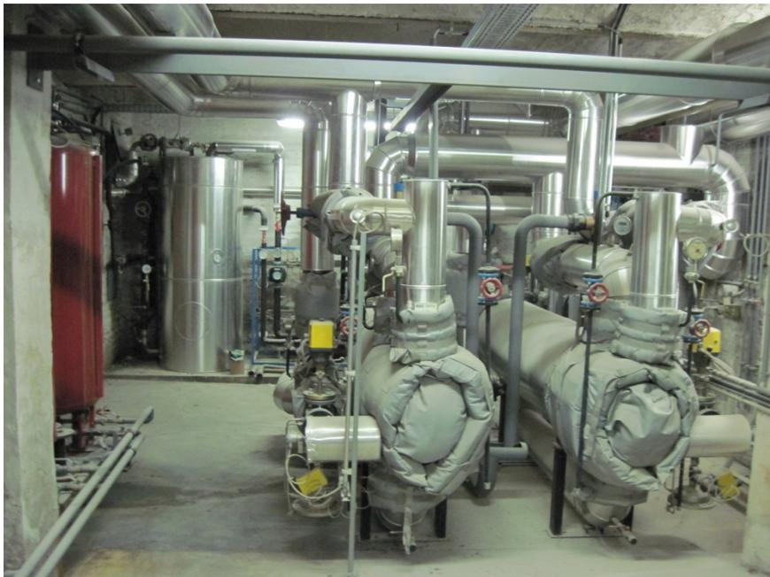
Abbildung 32: Wärmetauscher für Heizwärme und Brauchwasser (Quelle: e7)
