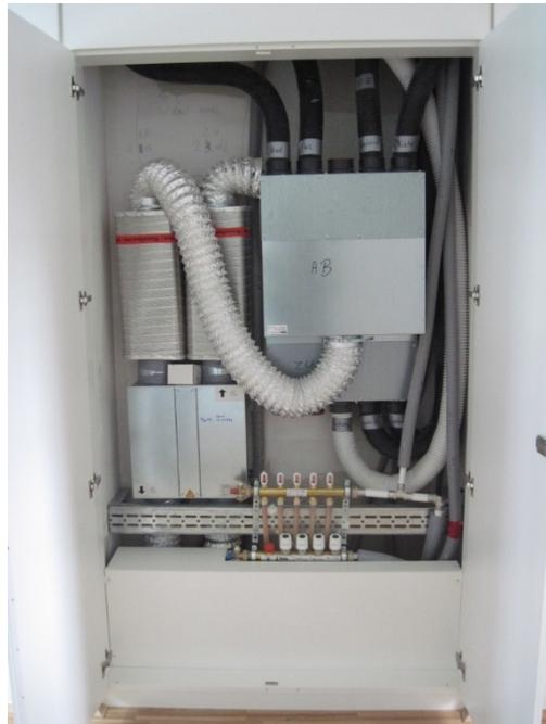
Abbildung 36: Volumenstromregelung über V-Box (Quelle e7)
