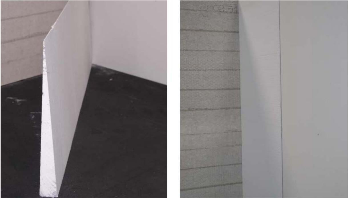
Abbildung 25: Dämmkeil zur Entschärfung von Wärmebrücken (Quelle: Promat GesmbH)
