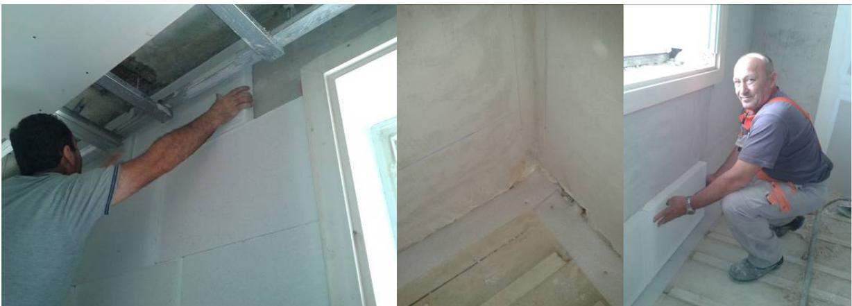
Abbildung 26: Fotos von Innendämmungsherstellung (Quelle: Architekten Kronreif\_Trimmel&Partner)
