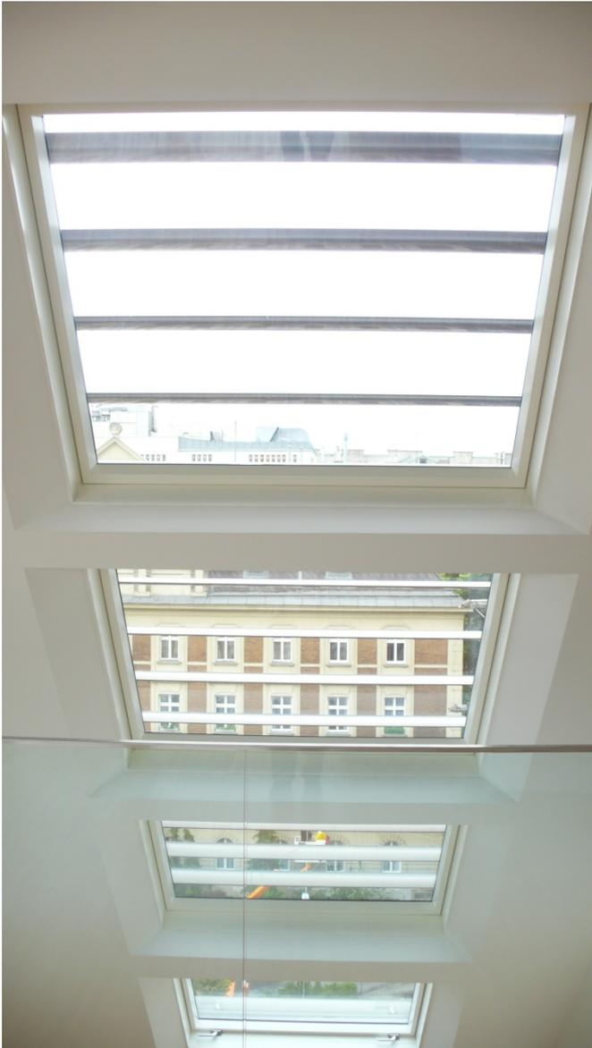
Abbildung 29: Kaiserstraße 7, Dachausbau, Lichtbänder in der Dachfläche, Blick nach außen (Foto: Oettl).
