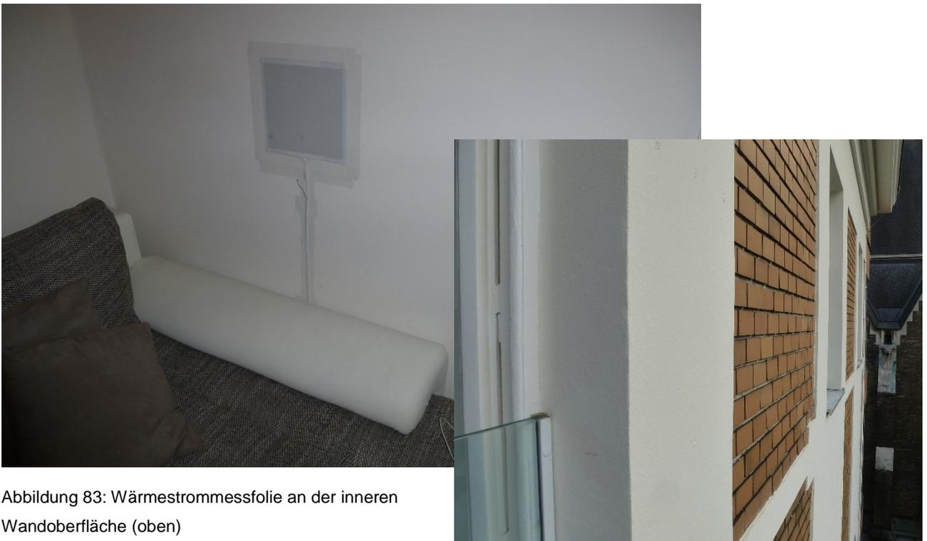
Abbildung 83: Wärmestrommessfolie an der inneren Wandoberfläche (oben)
