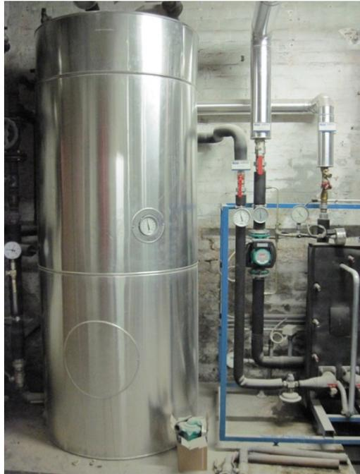
Abbildung 33: Warmwasserspeicher im Haustechnikraum für Erd- und 1. Obergeschoß (Quelle: e7)
