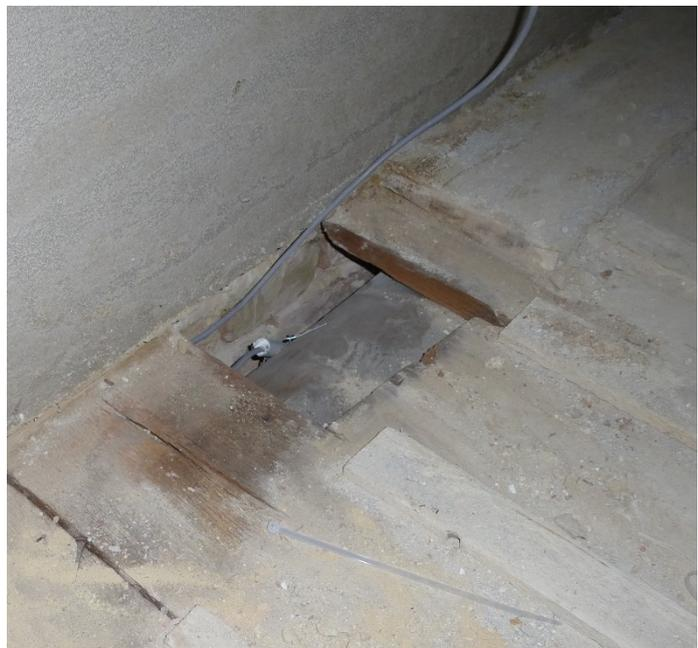
Abbildung 74: Sensor S14 an der Außenseite des Streichbalkens
