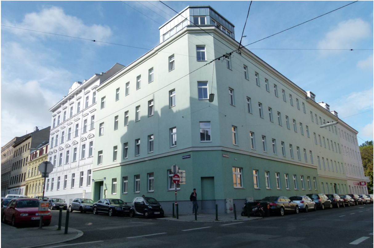
Abbildung 1 Ensemble David-Muhrengasse, Straßenansicht (Foto: POS Architekten, 2016)
