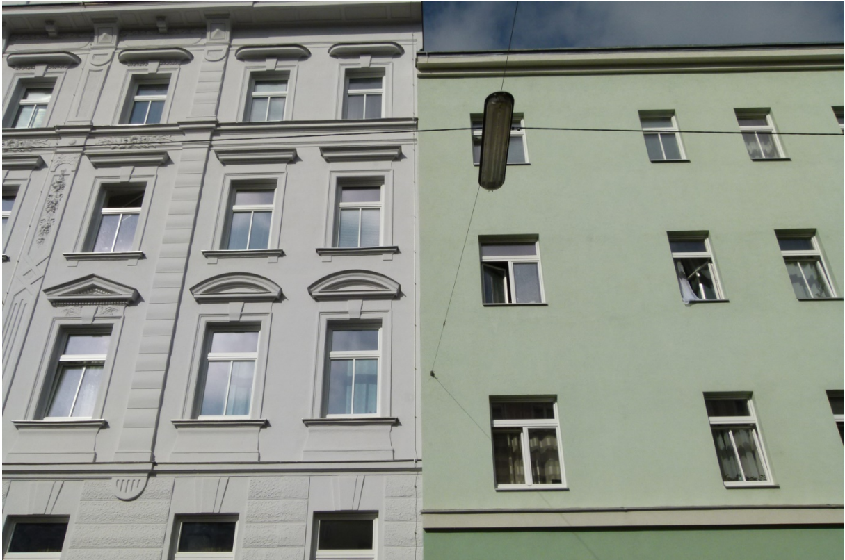
Abbildung 14 Fenster Muhrengasse 16 und 18 (Foto: POS Architekten)
