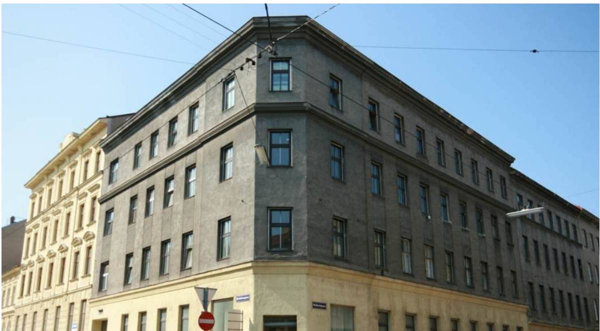
Abbildung 2 Ensemble David-Muhrengasse vor der Sanierung (Foto: bluesave, 2012)
