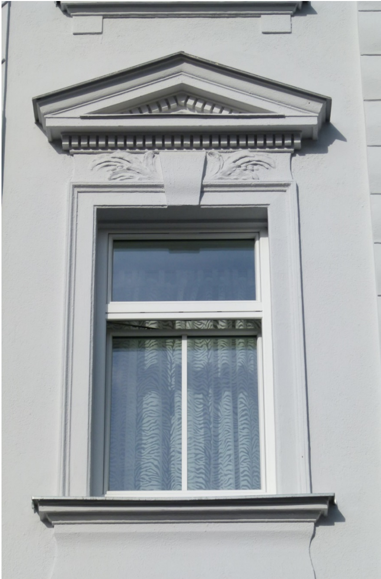
Abbildung 11 Neues Fenster in der Muhrengasse 18 (Foto: POS Architekten)
