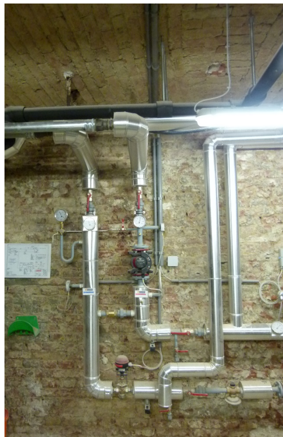
Abbildung 17 Links: Wärmetauscher Fernwärme zur Warmwasserbereitung; Rechts: Wärmeverteilung mit Wärmezählern
