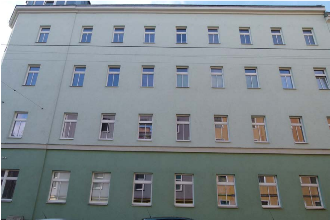
Abbildung 12 Fassade Davidgasse (Foto: POS Architekten)
