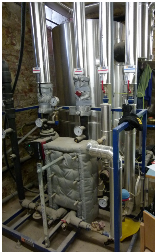
Abbildung 17 Links: Wärmetauscher Fernwärme zur Warmwasserbereitung; Rechts: Wärmeverteilung mit Wärmezählern
