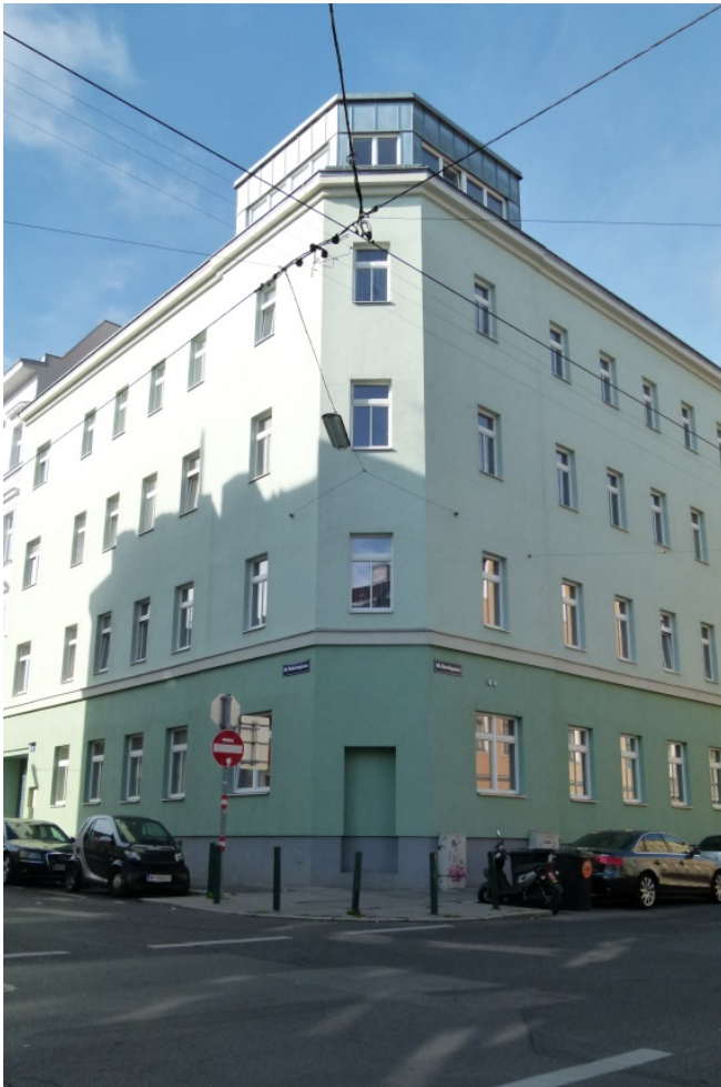
Abbildung 10 Dachausbau, Ecksituation David-Muhrengasse (Foto: POS Architekten)
