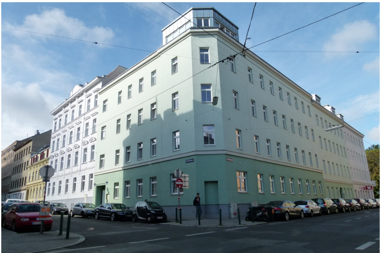
Demonstrationsprojekt DavidsCorner (Foto: pos architecture)
