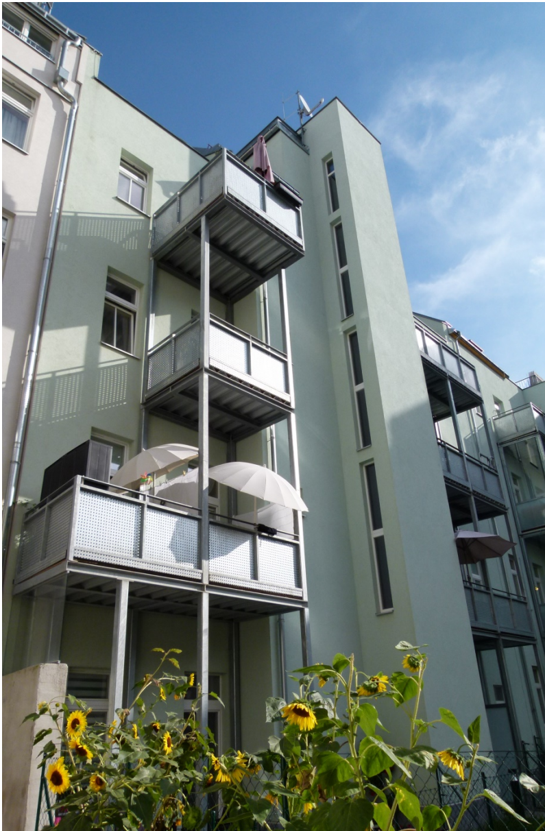
Abbildung 15 Balkonbauten (Foto: POS Architekten)
