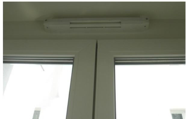
Abbildung 20: Fensterstocklüftung Innen (Foto: Manschein)
