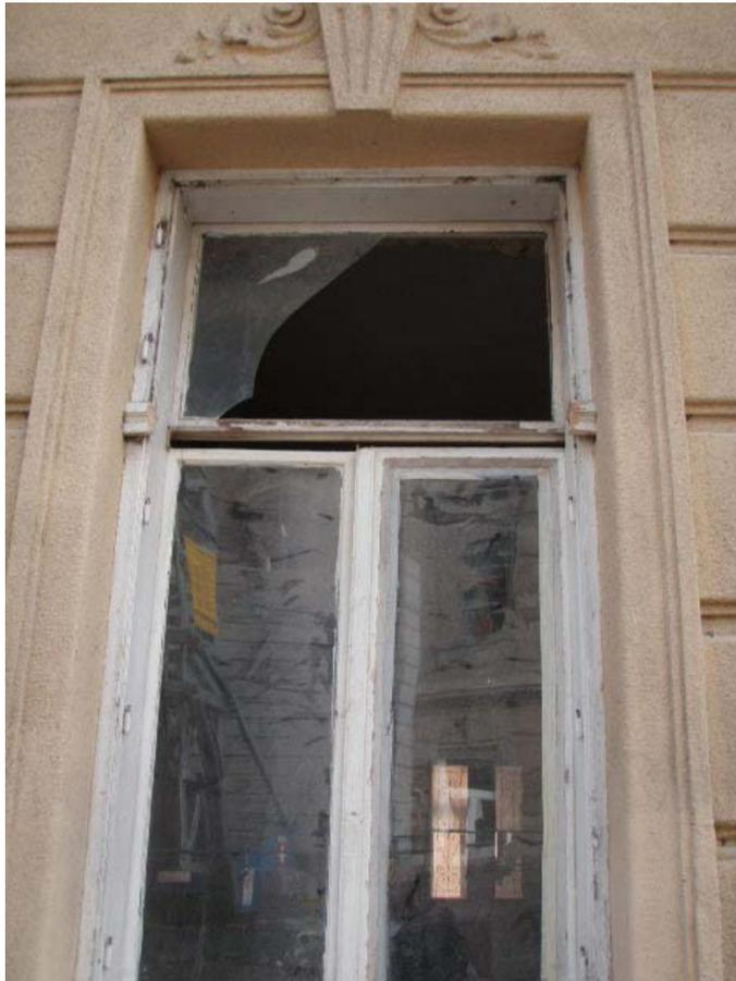
Abbildung 7: Originalfenster in Bestandsfassade, äußere Flügel bereits entfernt (Foto: Gassner&Partner)
