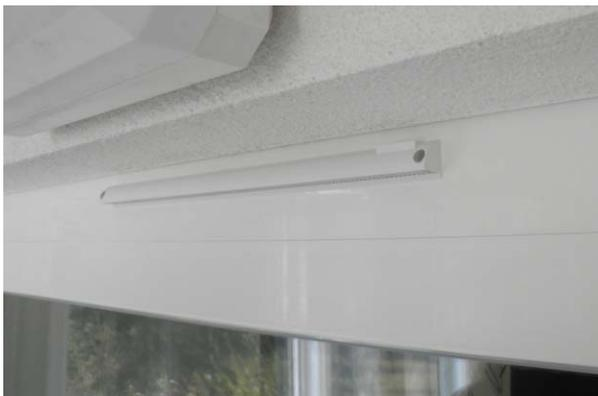
Abbildung 19: Fensterstocklüftung Außen (Foto: Manschein)
