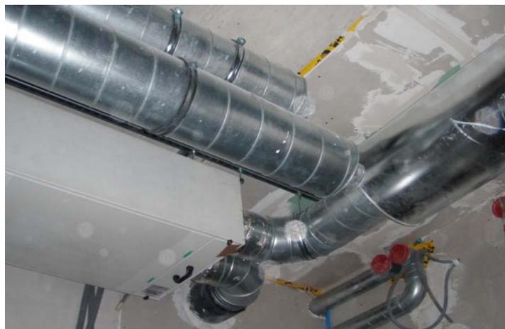
Abbildung 14: Zentrales Lüftungsgerät, Deckenintegriert im 1. Dachgeschoß (Foto: Gassner)
