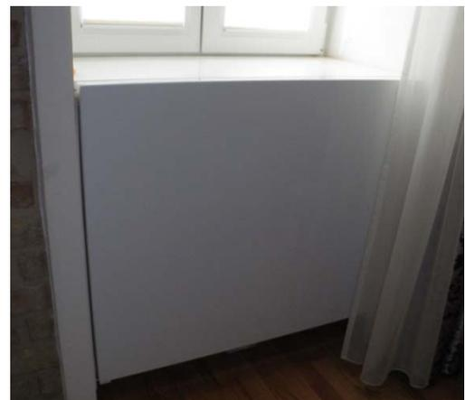
Abbildung 18: Parapetlüftung Innenansicht (Quelle: Gassner&Partner)
