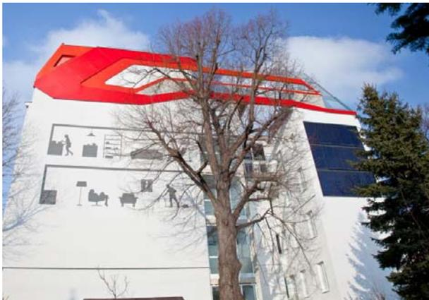
Abbildung 12: Südorientierte Feuermauer mit fassadenintegrierter solarthermischer Anlage (Foto: Gassner&Partner)
