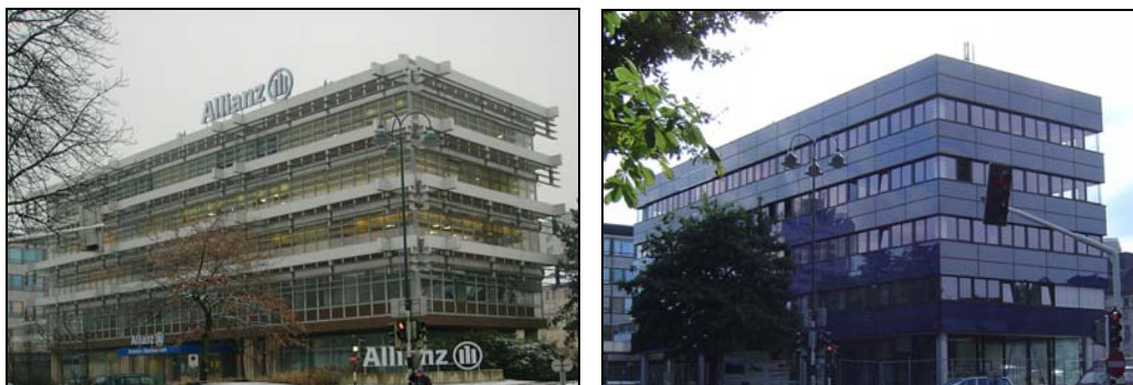
Abbildung 2: Bürogebäude in Linz vor und nach der Sanierung 1
