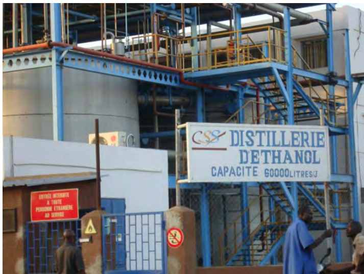
Abb. 2: Ethanolanlage der CSS
