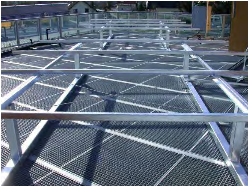
Abb. 110: Unterkonstruktion für die Kollektoren vor dem Anheben auf 24° Neigungswinkel
