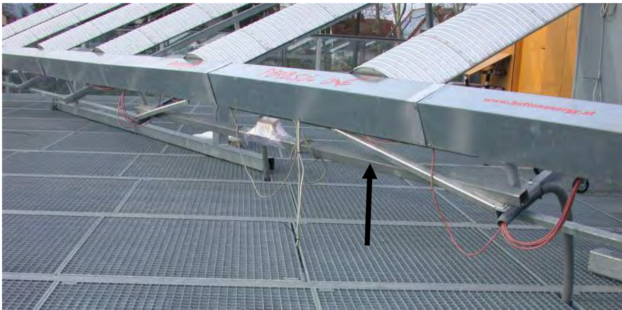
Abb. 56: Versteifungskonstruktion zur Stützung der beiden mittleren Kollektoren
