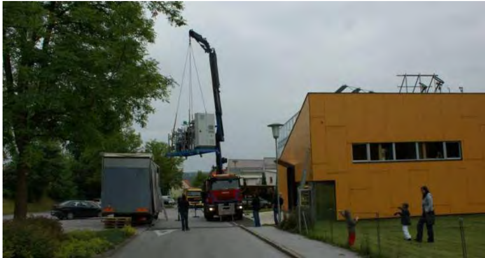
Abb. 117: Abladen der Dampfstrahlkältemaschine - auf dem Dach des Laborgebäudes sind Teile der Kollektoren zu sehen sowie die Wetterstation mit Schattenringpyranometer
