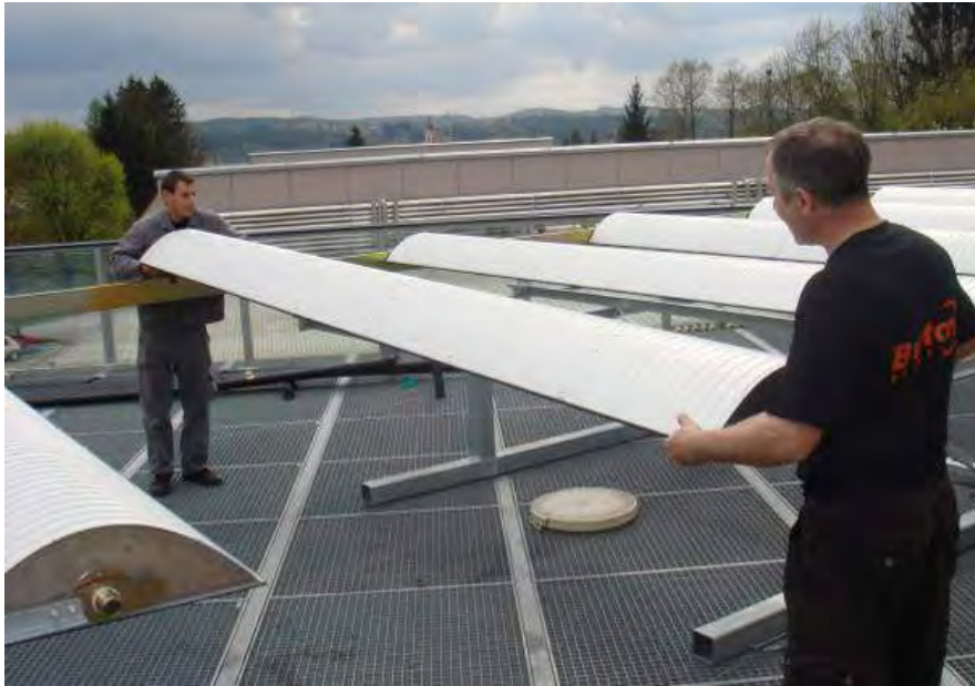
Abb. 112: Einhängen der einzelnen Kollektoren
