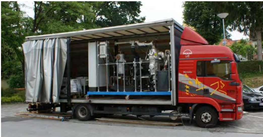
Abb. 116: Anlieferung der Dampfstrahlkältemaschine
