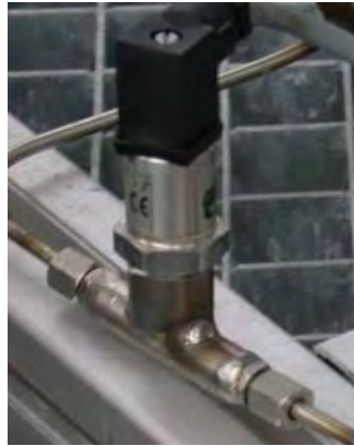
Abb. 63: Drucksensor im Kollektorkreis
