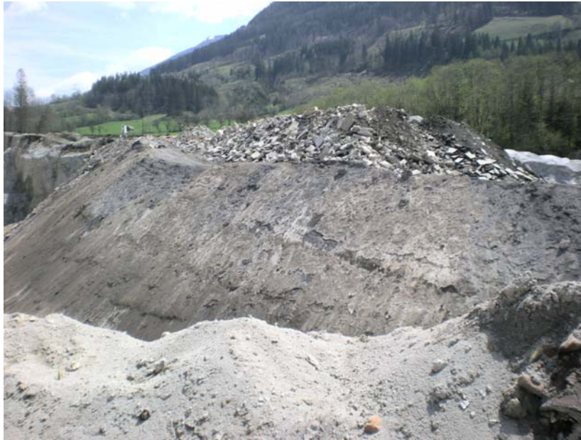
Abb.1 Stützdamm Werk Lassing
