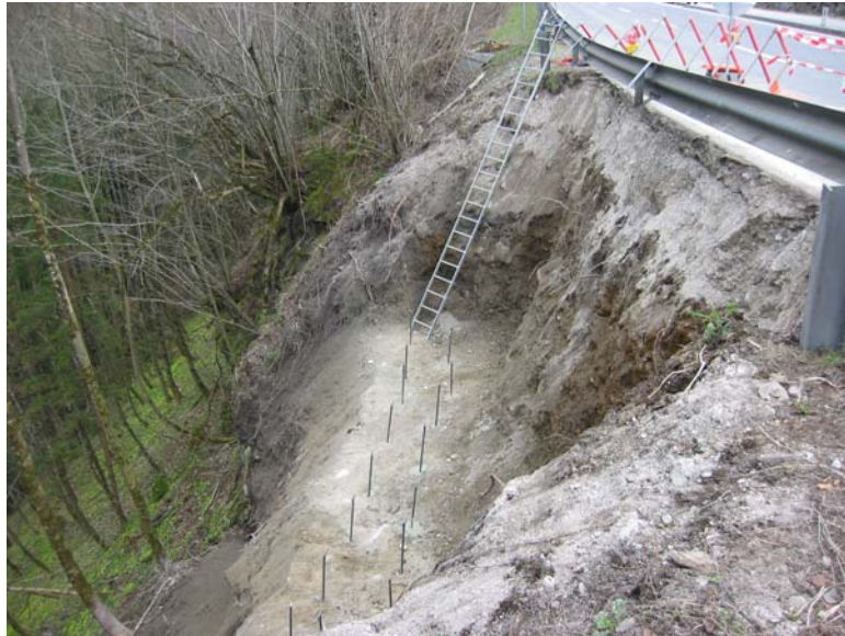
Abb. 3: Bundesstraße Großreifling vor der Auffüllung mit „Mixolith“
