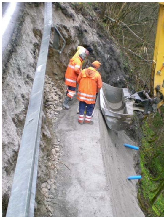
Abb. 4: Bundesstraße Großreifling während der Bauarbeiten
