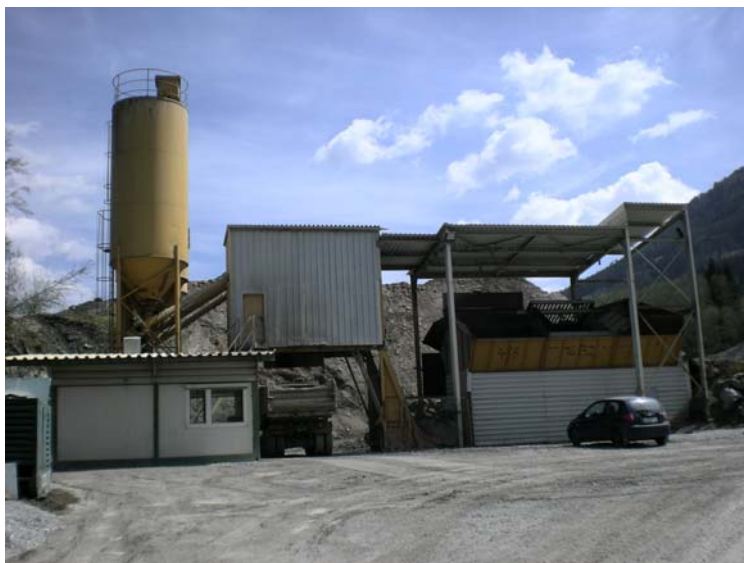
Abb. 5 Mischanlage Werk Lassing
