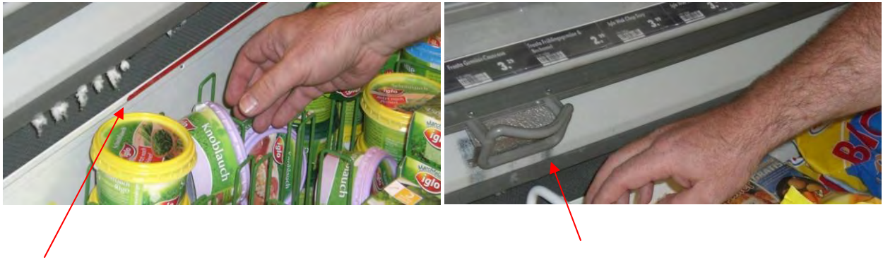
Abbildung 40: Beschickungsgrenzen an unterschiedlichen Kühlmöbeln
