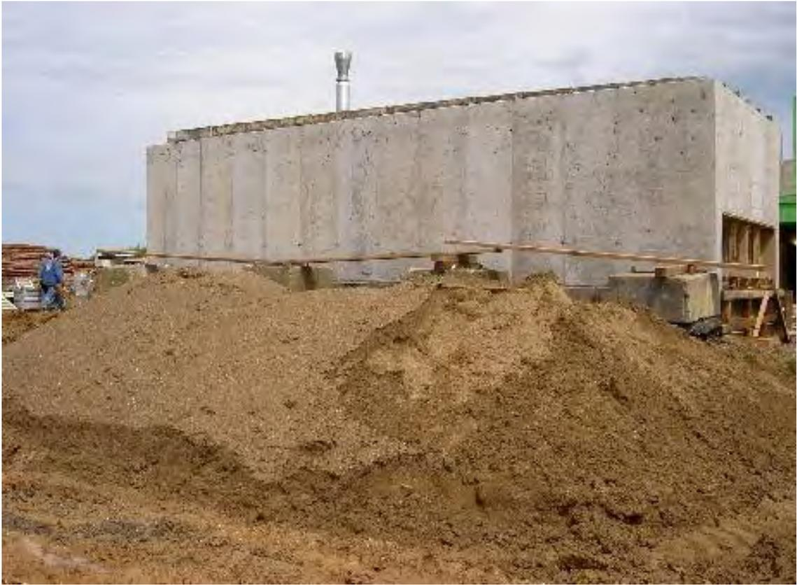
Abbildung 5: Feststoffbehälter in Betonbauweise nach vorgegebenem Schalungsplan
