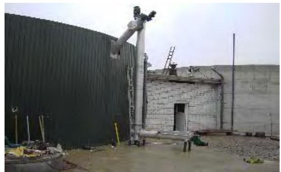
Abbildung 45: Komplettes Schneckensystem bei Hochfermenter
