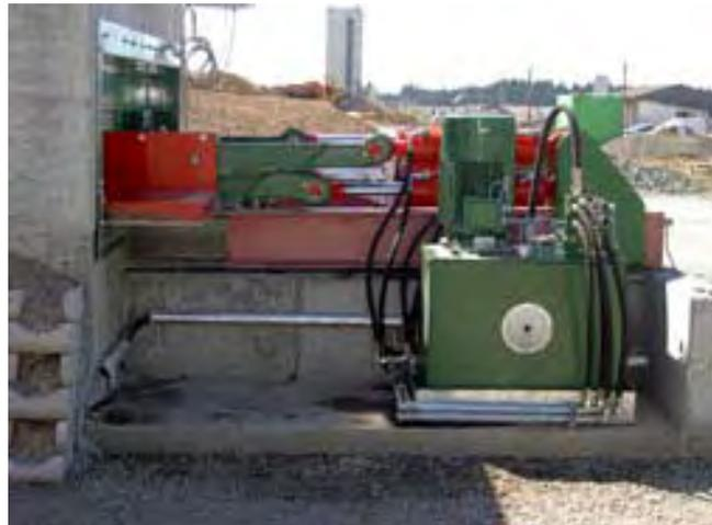
Abbildung 10: Zentrales Hydraulikaggregat mit einer Anschlussleistung von 9,2 – 11kW
