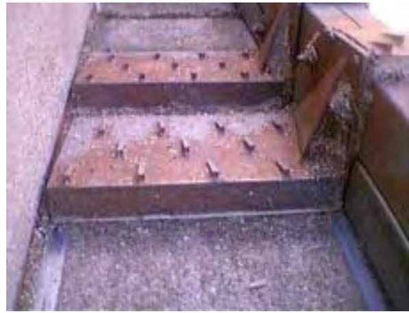
Abbildung 24: Extremer Verschleiß und Abrieb am Betonboden
