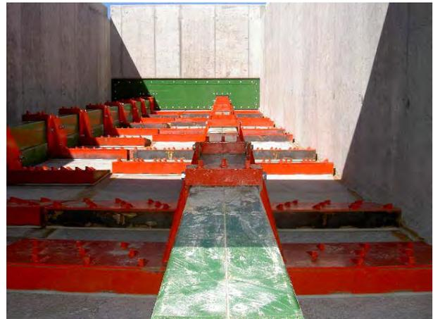
Abbildung 25: Einbau der Schubstangen und der Schieber (mit Kunststoffführungen) in den betonierten Feststoffbehälter
