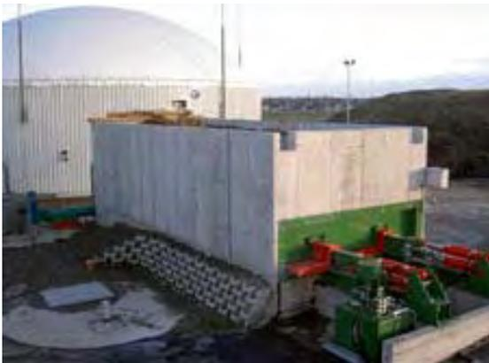
Abbildung 3: Betonbehälter mit gegenläufigem Schubbodensystem
