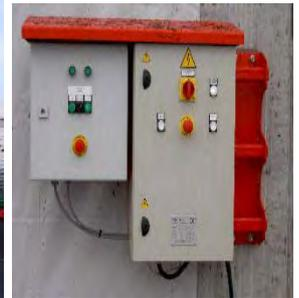
Abbildung 32: Montage der neuentwickelten Abdeckung und Anschluss an die Anlagen SPS
