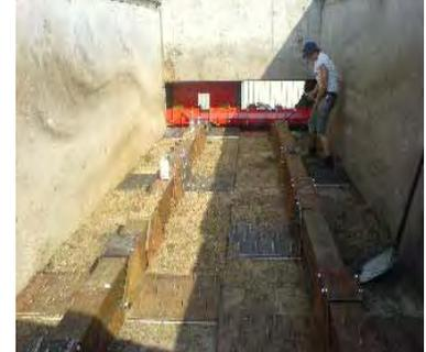
Abbildung 30: Kompletter Austausch des Schubbodens nach mehrwöchigem Testbetrieb, Neuanfertigung von Schubstangen und Schiebern, Nochmaliges Abschleifen und Versiegelung des Betonbodens mit Industrieanstrich
