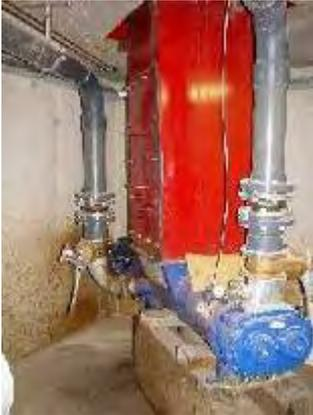
Abbildung 14: Fallschacht zur Einspülpumpe mit Ultraschall
