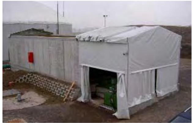
Abbildung 31: Neuaufbau der Einbringtechnik mit geschlossener und offener Dachabdeckung
