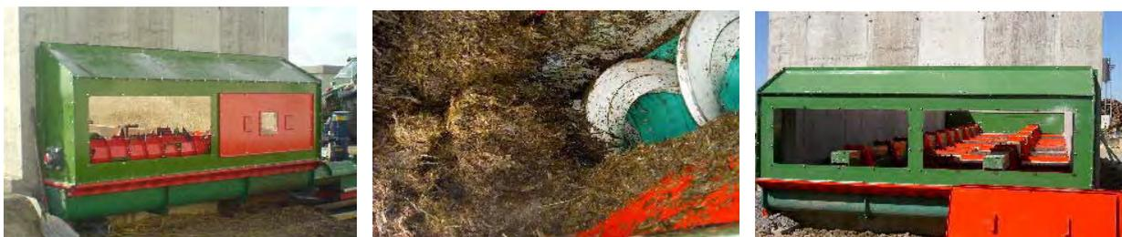
Abbildung 35: Einbau einer SPS – gesteuerten Dosierwalze mit Druckumschaltung, Abbau der kompletten Einhausung und Montage des hydr. Getriebemotores und der Lagerung.
