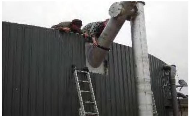
Abbildung 43: Einbau von Stopfschnecke und Steigschnecke mit Ringraumdichtung
