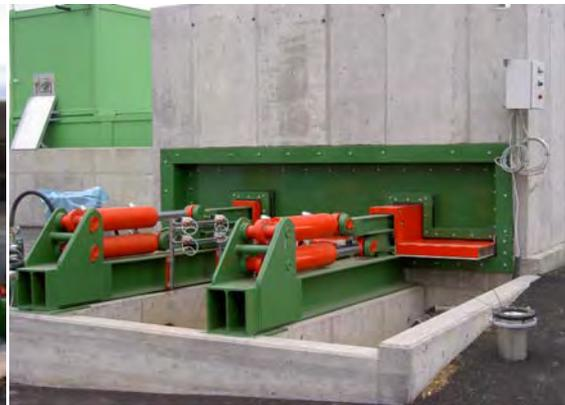
Abbildung 4: Schiebergestänge mit übereinanderliegenden Hydraulikzylinder
