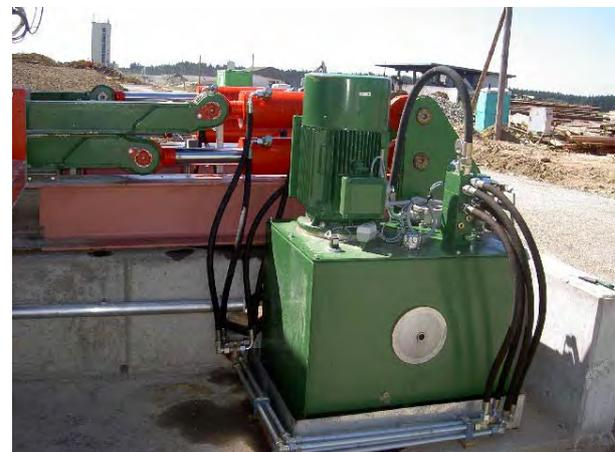
Abbildung 26: Aufbau der Hydraulikzylinder auf die Schubstangen und Anschluss des Aggregates an die SPS, - Rohrleitungsbau,
