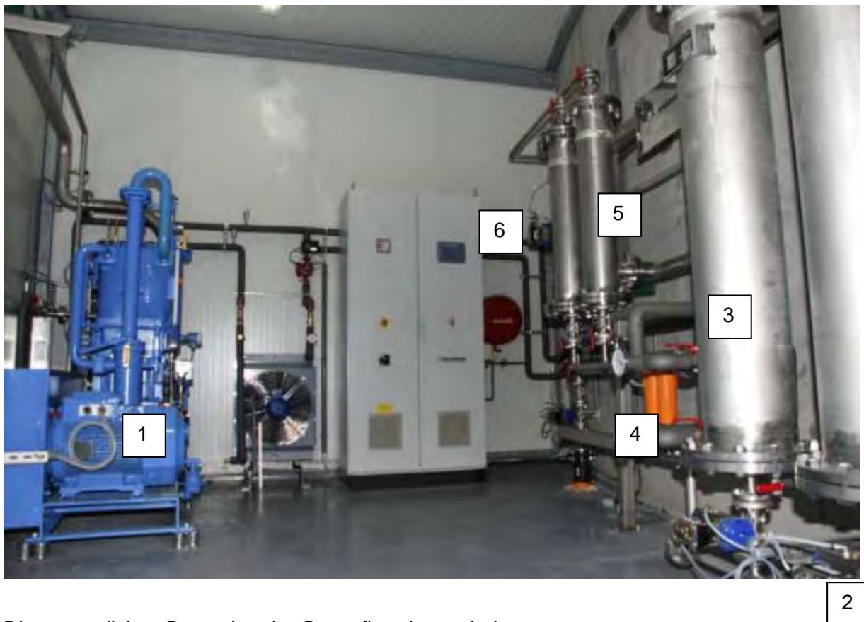
Foto 7 Die Gasaufbereitung (Quelle: AGRAR PLUS)
