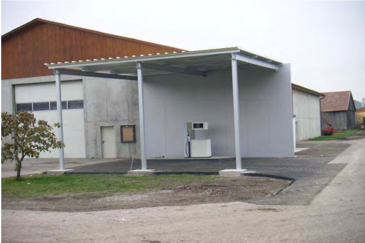
Foto 5: Tankstellenerriichtung Phase II (Quelle: AGRAR PLUS)
