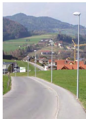
Durch moderne, digitale Intelligenz in den Leuchten, wird in den Nachtstunden, zwischen 22:00 und 5:00 morgens, die Lichtleistung um 50% und somit die Energieaufnahme um 30% abgesenkt und, neben der Erhöhung der Verkehrssicherheit, der Verbesserung des Ortsbildes in der Nacht, auch nachhaltig Energie eingespart.
