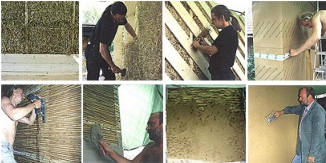
Abbildung 28: Errichtung der Probewand
